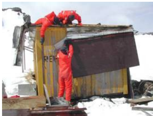
Figura 5 - Procedimento de remoção das folhas de alumínio e placas de compensado de recobrimento da cobertura.
