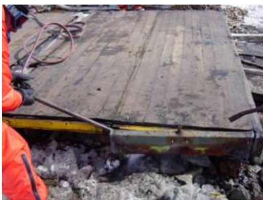
Figura 10 – Desconexão dos painéis do piso através da ruptura dos perfis de encaixe tipo trilho em formato “C”.
