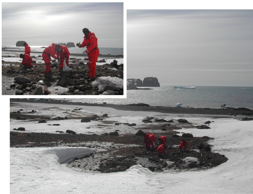
Figura 14 – “Pente fino” realizado na área antes ocupada pelo refúgio e no entorno imediato, finalizando as atividades de desmonte e remoção do Refúgio Padre Balduino Rambo.
