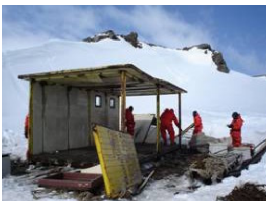
Figura 8 - Os painéis externos puderam ser retirados na sua integridade e com relativa facilidade a partir da ruptura dos parafusos de fixação.
