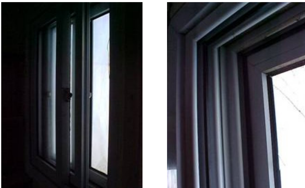
Figura 15 – Esquadria em PVC, com 3 folhas de correr e uma tela metálica externa fixa, que se manteve intacta mesmo com o provável impacto causado pela queda do módulo de seus pilaretes de fixação.
