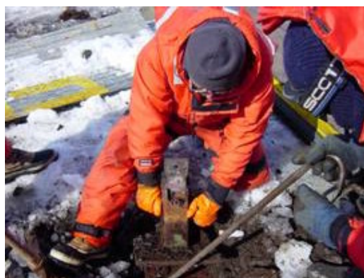
Figura 11 – Retirada das sapatas. Destaca-se que a não utilização de concreto facilitou a retirada dos elementos enterrados.
