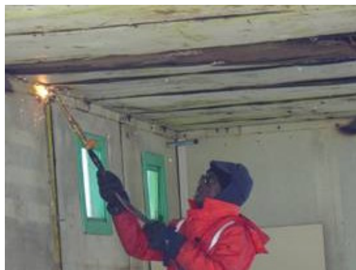
Figura 7 - Retirada dos parafusos de fixação entre painéis e perfis metálicos (imagem: Andrei Polejack).
