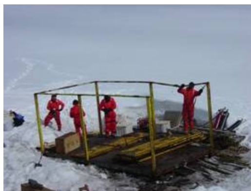
Figura 9 – Remoção dos componentes estruturais metálicos, facilitado pela permanência dos painéis de piso.
