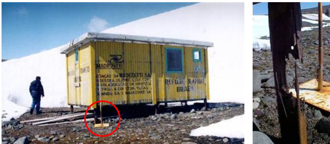
Figura 1 – À esquerda, situação do Refúgio em 2002, sendo perceptível o estado avançado de degradação dos pilaretes de apoio, conforme imagem do detalhe à direita (Alvarez, 2002).
