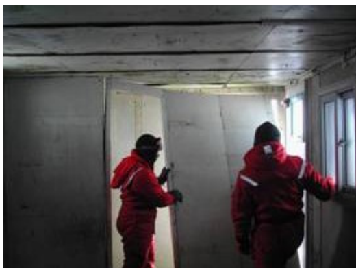
Figura 6 - Retirada das anteparas internas.
