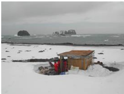
Figura 4 – Início do desmonte dos painéis internos e externos.
