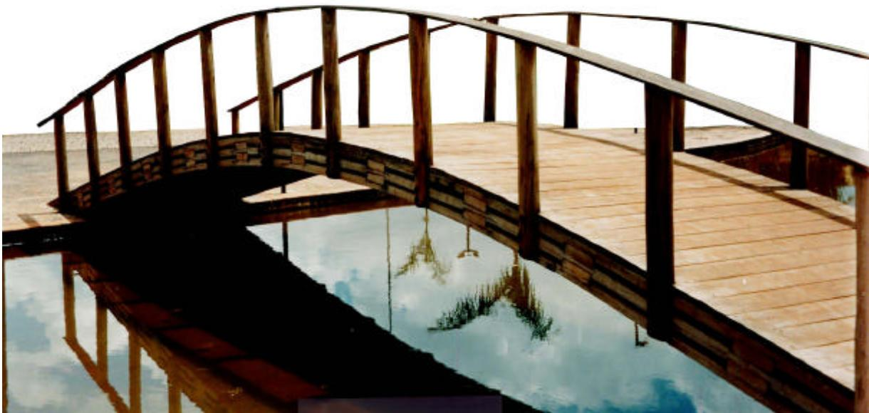
Figura 9 – Exemplo de ponte construída no PARNAMAR, destacando-se a impossibilidade de utilização de maquinários e/ou pessoal especializado na construção. Observa-se que o guarda corpo utiliza pilaretes semelhantes ao adotado para sustentação das placas informativas.
