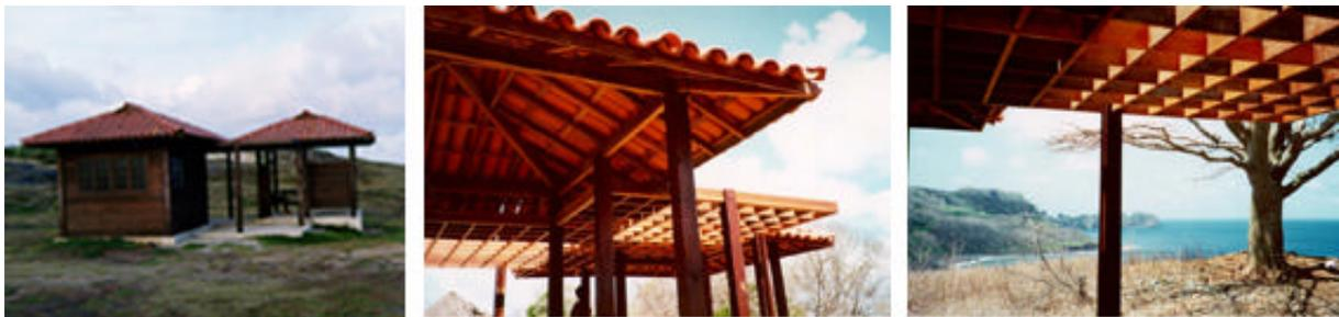
Figura 7 – Vista do "PIC" tipo 2 e detalhes do pilar e do pergolado utilizado também nos quiosques de descanso e informações; a estrutura mais simples dos "PICs".
