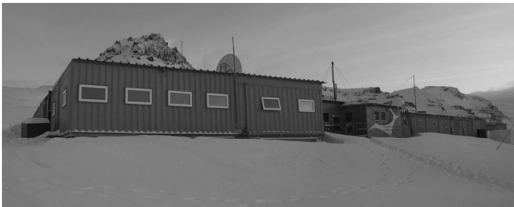
Figura 2. Vista frontal da EACF em junho de 2007. Destaca-se que no inverno, praticamente todas as unidades que compõem a Estação Ferraz permanecem cobertas de gelo e neve.
