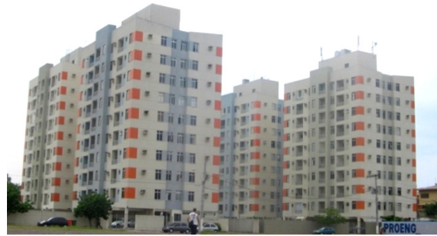
Figura 5 - Exemplo de tipologia de condomínio residencial em Jardim Camburi, com fachadas semelhantes para todas as orientações. Fonte: FANTICELE; ALVAREZ, 2008.
