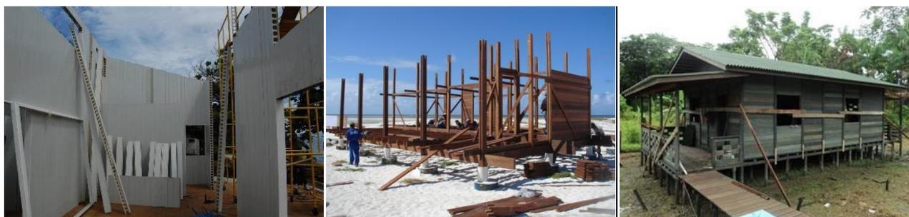
**Figura 3:** Exemplo de sistema construtivo em concreto-PVC, na Ilha de Trindade (à esquerda); em madeira serrada, no Atol das Rocas (ao centro); e em madeira plástica, no Pará [13].
