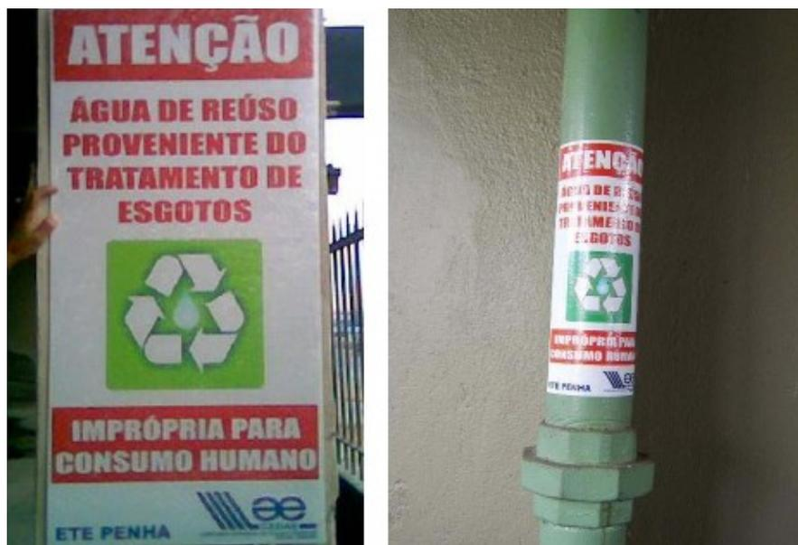
**Figura 17. Identificação para sistemas hidráulicos não convencionais**
