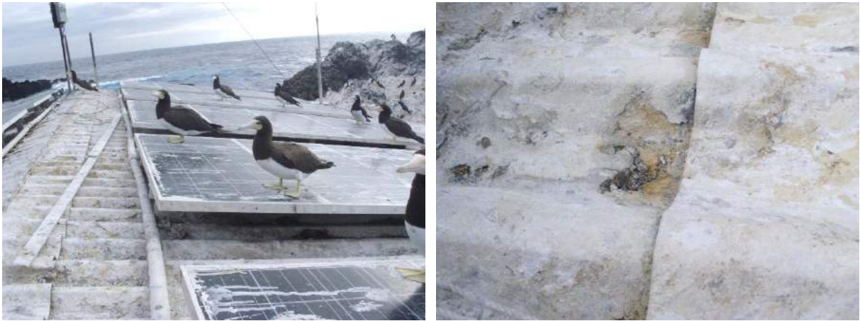
Figura 6: À esquerda, aves sobre o telhado da Estação Científica do ASPSP. À direita, telha metálica termoacústica com região totalmente deteriorada pelo guano das aves, podendo se observar a camada de isolamento da telha na cor amarela.
