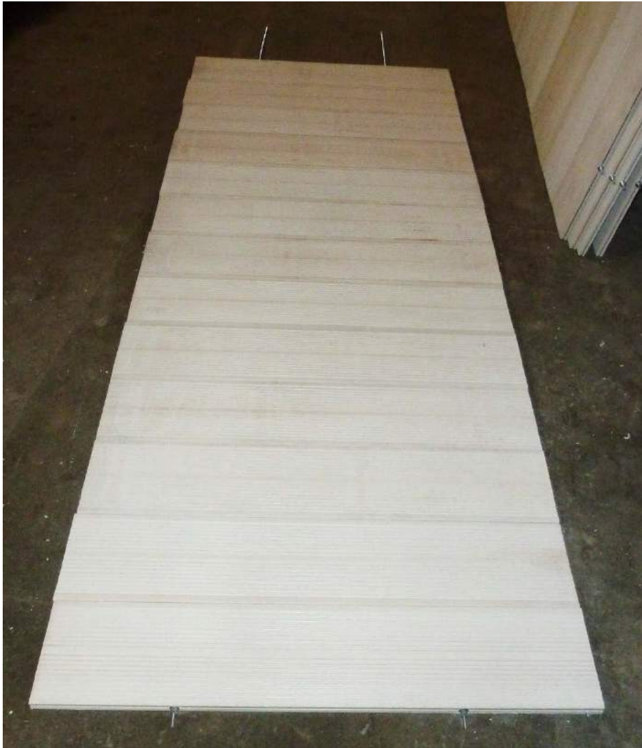
Figura 57: Parede externa do painel de vedação finalizada.
