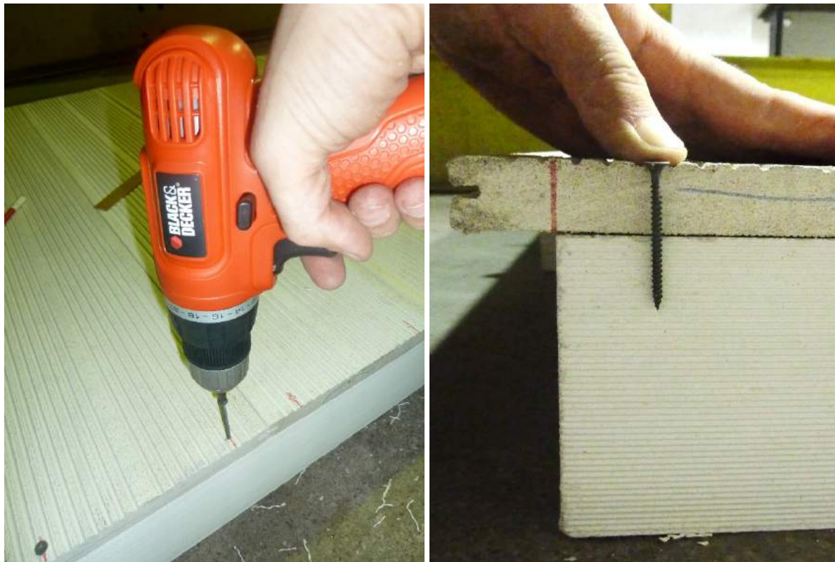
Figura 61: À esquerda, processo de aparafusamento, e à direita, imagem mostrando o comprimento do parafuso que penetra nos montantes.
