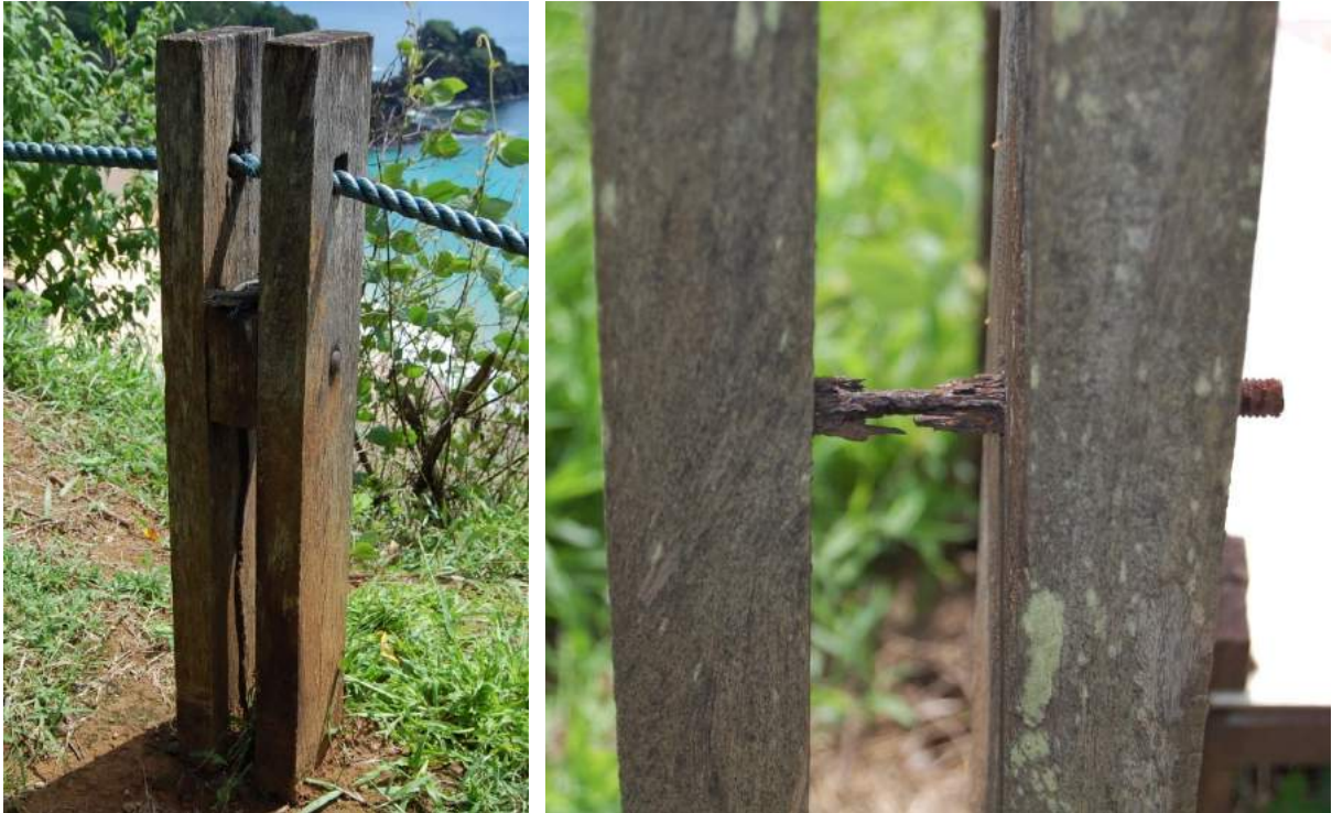
Figura 5: Parafuso de pilarete de guarda-corpo totalmente corroído devido à névoa salina. Arquipélago de Fernando de Noronha.
