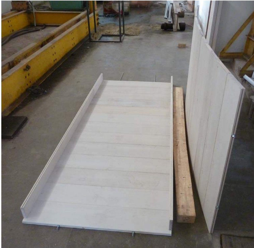
Figura 62: Conjunto (parede externa parafusada aos montantes) já rotacionado e parede interna prestes a ser posicionada sobre os montantes para aparafusamento.
