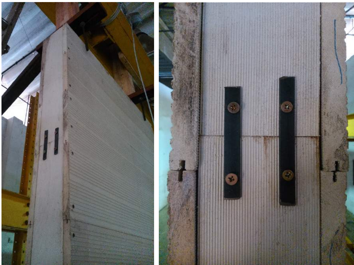
Figura 88: Painel após a fixação das chapas de aço ligando os montantes. As imagens mostram a lateral esquerda do painel. O mesmo procedimento foi feito na lateral direita.
