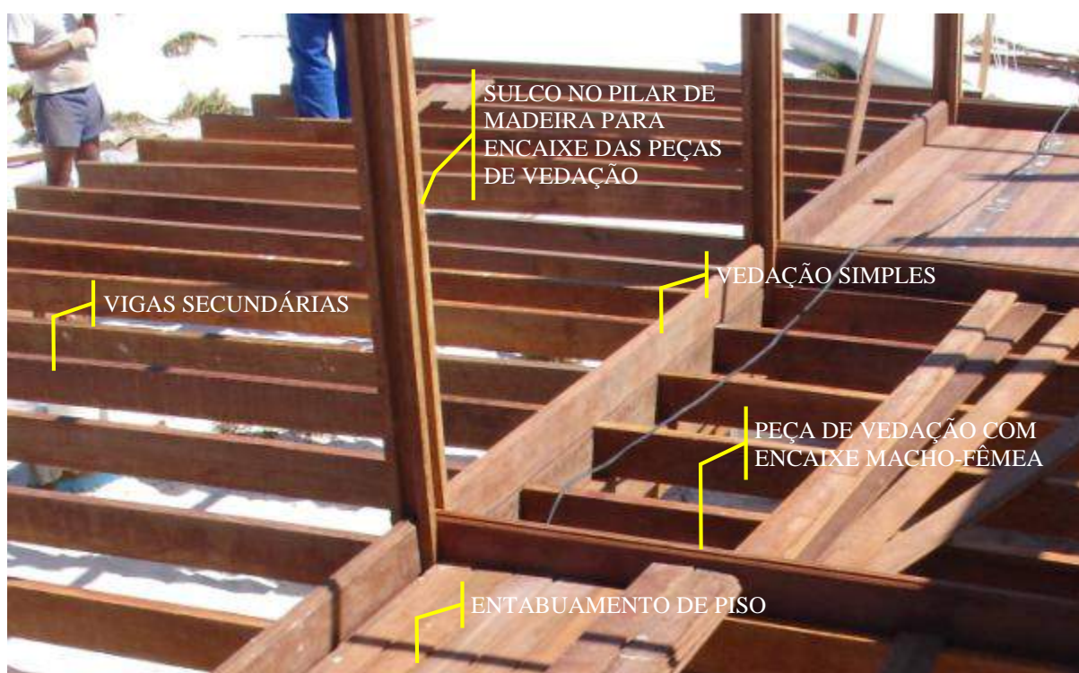
Figura 21: Peças de madeira serrada das vedações com encaixe macho-fêmea.
