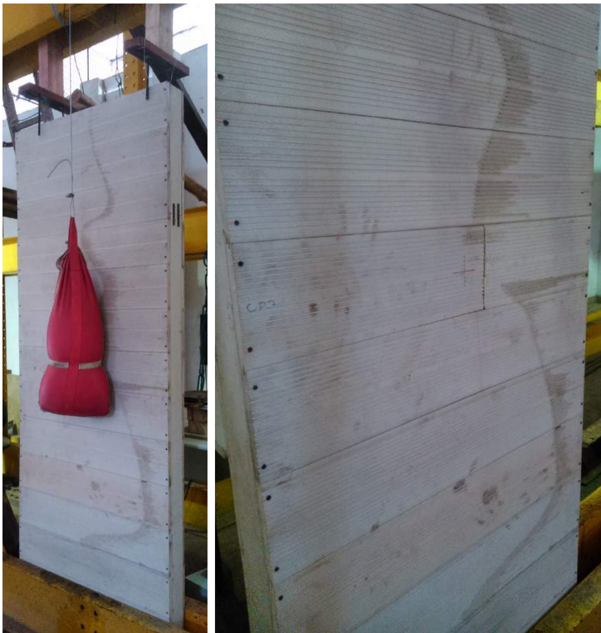
Figura 94: CP 3 após os impactos de 1,20m (à esquerda) e 1,80m (à direita). Não houve desestabilização ou ruína do protótipo.
