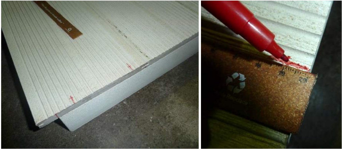
Figura 61: À esquerda, processo de aparafusamento, e à direita, imagem mostrando o comprimento do parafuso que penetra nos montantes.
