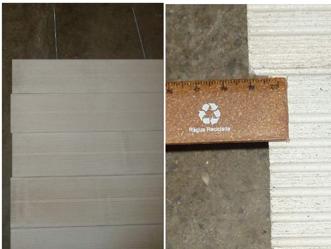
Figura 58: Lateral da parede externa com peças desalinhadas (à esquerda) e diferença de cerca de 7mm no alinhamento entre duas delas (à direita).
