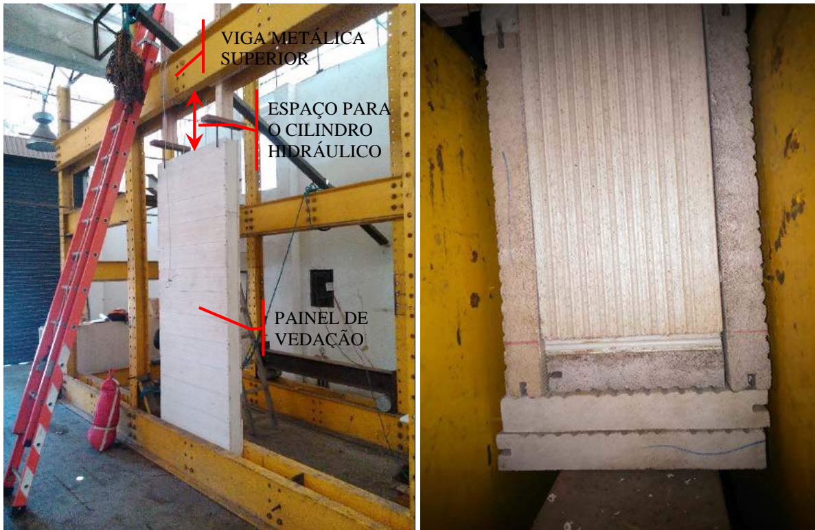
Figura 67: Posicionamento do protótipo no quadro rígido. À direita, detalhe do engaste na base do painel.
