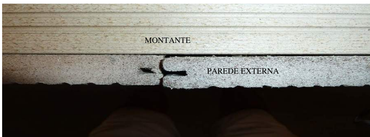
Figura 65: Frestas com cerca de 1mm a 2mm ocorridas no aparafusamento.
