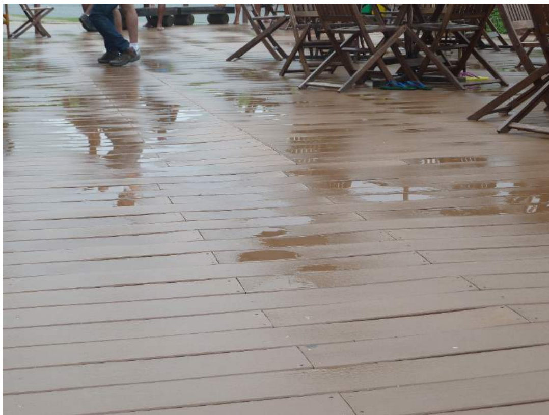
Figura 10: Ondulação em deck de madeira plástica causada, provavelmente, pela dilatação térmica e absorção de água das peças.
