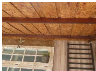
Figura 12: Utilização de OSB e madeira para a cobertura da lanchonete
