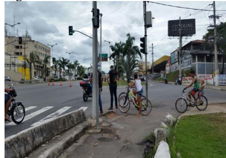
Figura 22a. Trecho sem estrutura e sinalização
