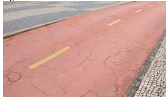
Figura 14a. Trecho de ciclovia com desnível.
