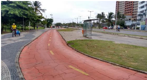
Figura 14. Trecho de ciclovia com rachadura.
