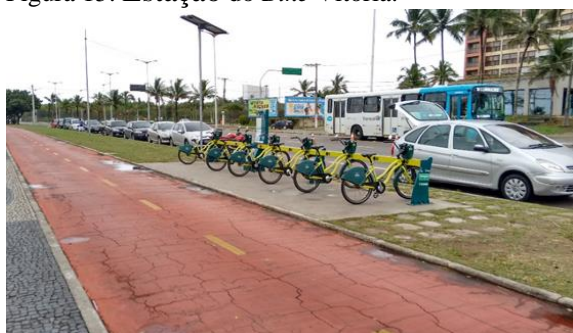
Figura 15. Estação do Bike Vitória.
