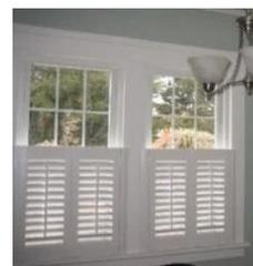
Janela com vidro no sistema de abrir e venezianas fixas no sistema de abrir
