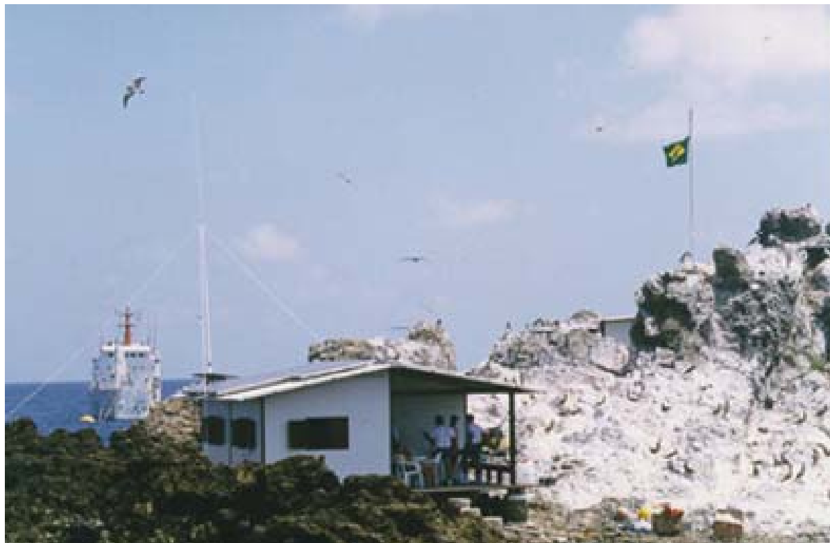
Figura 5 -Vista da Estação.
