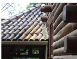
FIGURA 8 – Sistema de drenagem de águas pluviais utilizados em algumas residências avaliadas.
