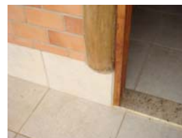
FIGURA 6 – Possíveis medidas construtivas para afastar as peças de madeira do solo.
