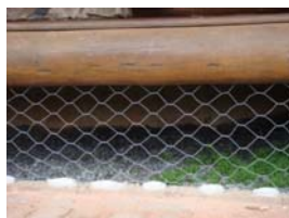
FIGURA 6 – Possíveis medidas construtivas para afastar as peças de madeira do solo.
