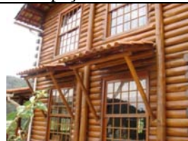
FIGURA 7 – Proteção das janelas com coberturas exclusivas.
