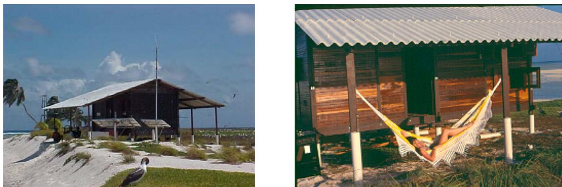
**Figura 5 - O projeto para o Atol das Rocas foi desenvolvido baseado na relação de dimensionamento das peças x transporte x disponibilidade no mercado, sendo também considerada a modulação entre pilares que permitisse a instalação de prendedores de rede, visto os usuários, quase sempre oriundos da região Nordeste, estarem habituados ao uso cotidiano desse equipamento.**
