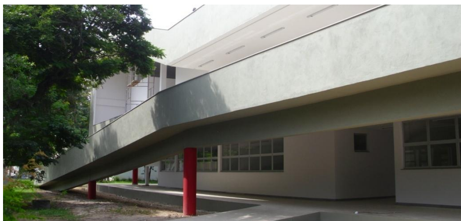
FIGURA 1 – O Edifício Administrativo do Centro de Artes da UFES.
