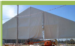
Figura 3 - Estrutura desmontável permite o reaproveitamento dos materiais
