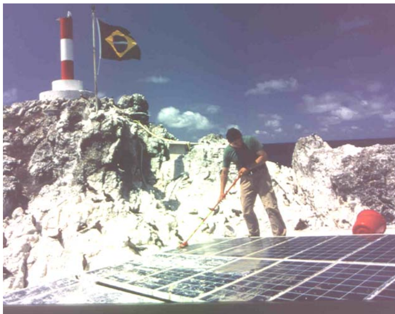
Figura 7 – Adoção do sistema de placas fotovoltaicas para captação de energia, instaladas sobre a cobertura. A limpeza é efetuada a cada 3 ou 4 dias em função da grande quantidade de aves no local. Foto: acervo LPP/UFES
