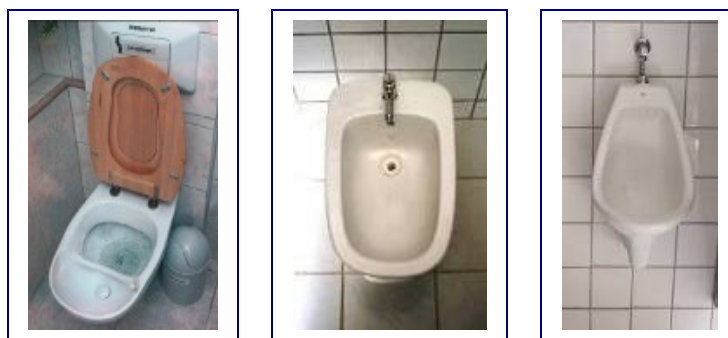
Figura 1 – Exemplos de equipamentos segregadores de urina
