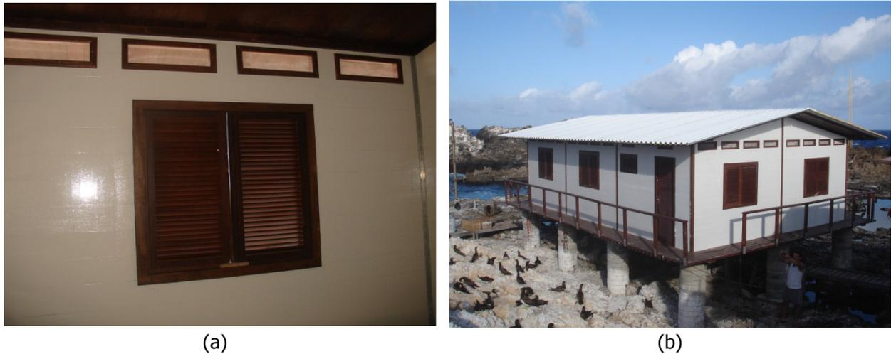
Figura 8 – Em (a). detalhe da janela em duas folhas com persianas móveis e esquadria de ventilação na porção superior da antepara; em (b) vista geral da estação científica.
