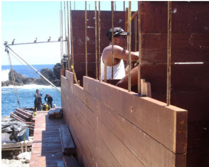
Figura 6 – Peças de associação dos painéis, contribuindo para a conformação de uma estrutura monobloco.
