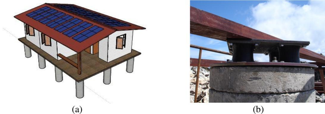
Figura 4 – (a) Maquete eletrônica da segunda ECASPP, e (b), detalhe dos amortecedores em neoprene e vigota de apoio do piso.
