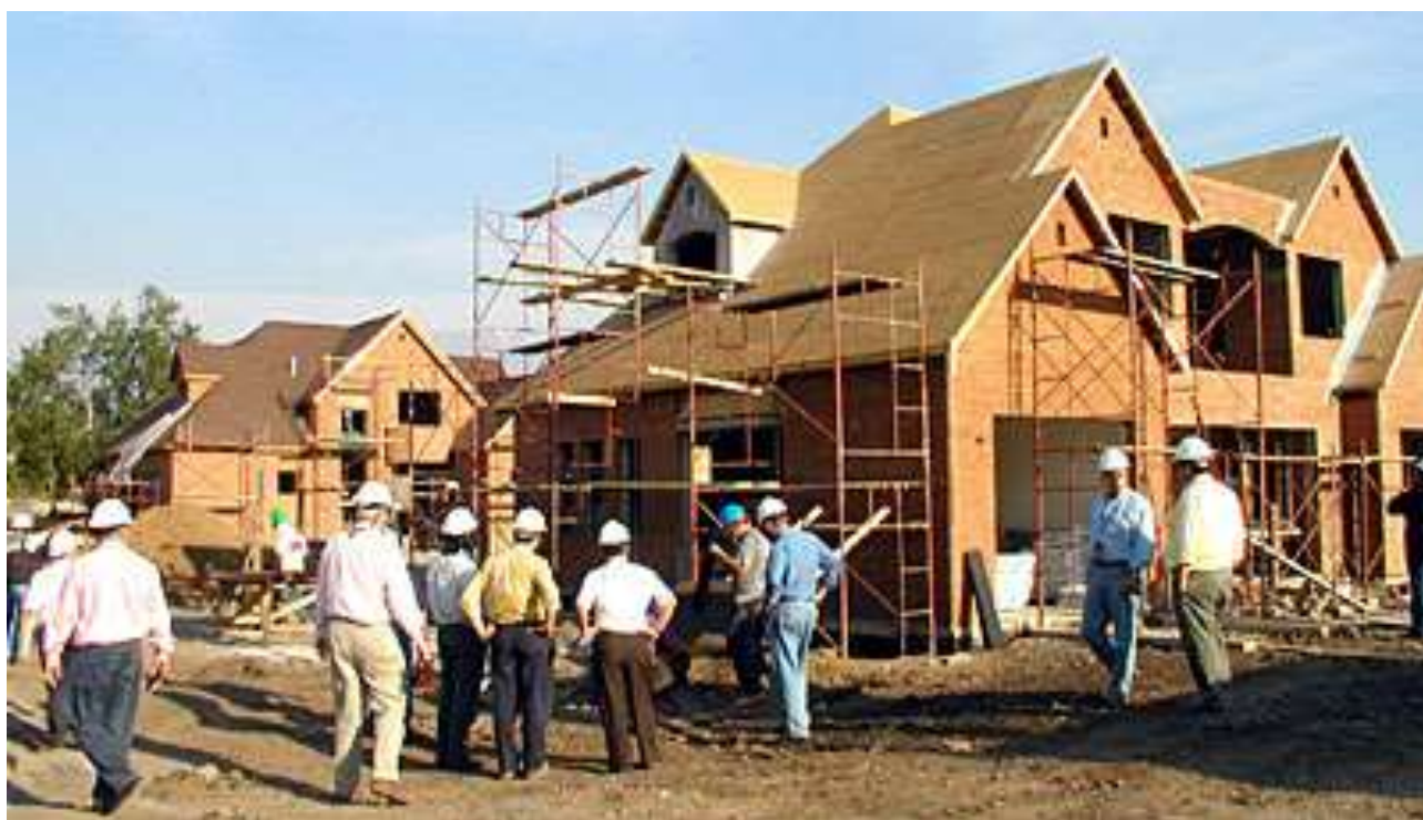
Figura 1: Exemplo de construção em steelframe que adota uma tipologia exógena ao nosso clima e a nossa cultura em favor de uma padronização cultural e também construtiva. Fonte: Disponível em: < http://www.metalica.com.br >, acesso em 2003.
