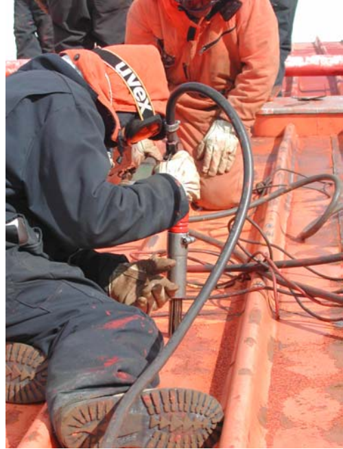
Figura 6 – Equipamento utilizado para a remoção das partes corroídas de superfícies metálicas corrugadas.
