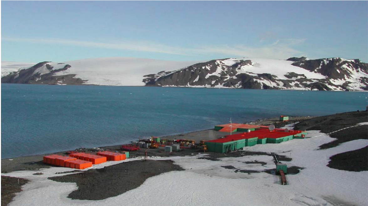
Figura 10 – Vista geral da EACF após a implementação do Plano de Ordenamento Frontal.
