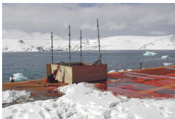
Figura 12 – Proteção lateral da área em tratamento. As anteparas auxiliam na contenção das partículas, embora não evitem totalmente a dispersão em função dos fortes e constantes ventos no local.
