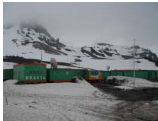
Figura 3 - A Estação Antártica Comandante Ferraz em janeiro de 2004, com capacidade atual de abrigar cerca de 40 pessoas em 64 unidades modulares.
