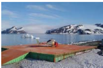
Figura 11 – Vista do heliponto após o tratamento da superfície horizontal. A área plana e sem rugosidades permite o estabelecimento de uma relação confiável de área tratada x resíduos produzidos.
