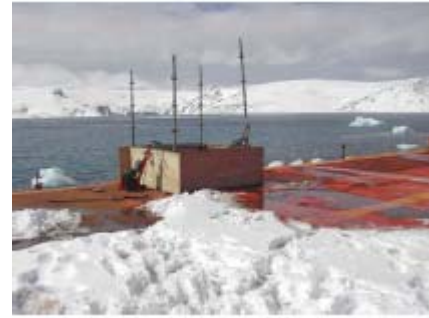
Figura 12 – Proteção lateral da área em tratamento. As anteparas auxiliam na contenção das partículas, embora não evitem totalmente a dispersão em função dos fortes e constantes ventos no local.
