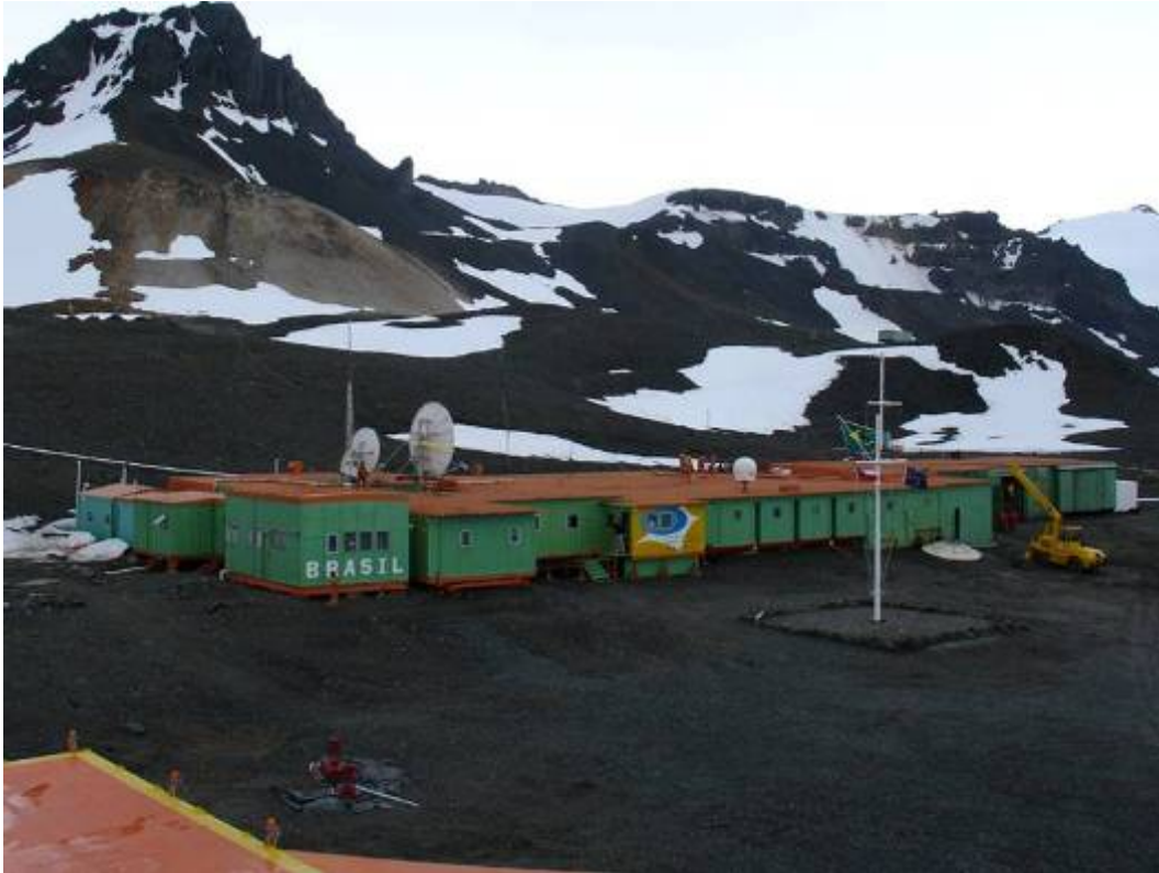
Figura 3 . Visão frontal da Estação Antártica Comandante Ferraz. Fonte: Acervo LPP/UFES.
