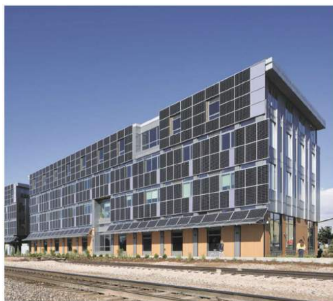
Figura 7 - Componentes fotovoltaicos integrados a fachada do edifício Boulder Commons , localizado em Boulder, Colorado (EUA).
