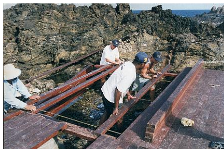
Figura 6 – À esquerda, croqui do sistema viga-laje e à direita, montagem com a colocação das peças de madeira unidas através de barras rosqueadas. Fonte: ALVAREZ, MELO e MELLO, 2000.
