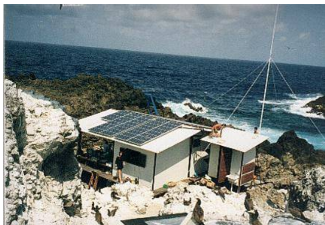
Figura 7 – Vista geral da edificação principal da Estação Científica, e as placas fotovoltaicas dispostas no telhado de forma a manterem dois sistemas independentes com a mesma capacidade de captação solar. Fonte: LPP/UFES, 2000.
