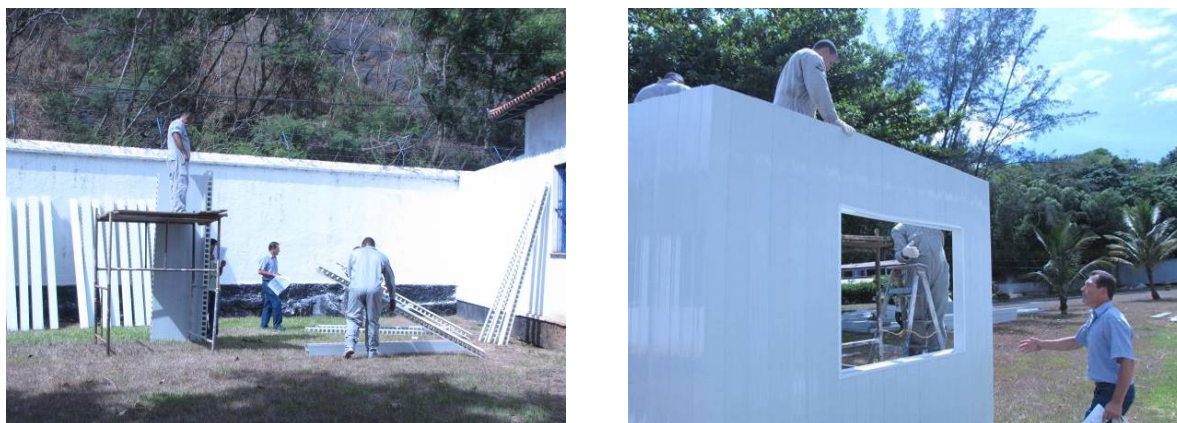
Figura 8 - À esquerda, início da pré-montagem na EAMES e à direita, a montagem da parede de um dos dormitórios.
