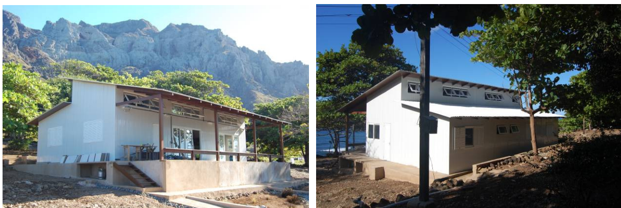
Figura 9 - Vistas gerais da ECIT na etapa de finalização das obras
