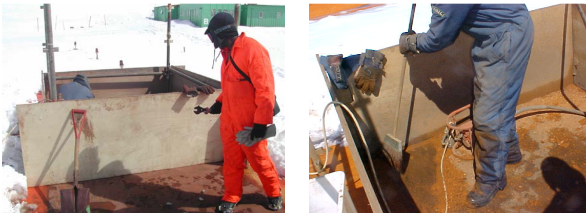
Figura 1 - À esquerda, painéis protetores contra a ação dos ventos sobre os resíduos produzidos nos processos de tratamento das estruturas metálicas e, à direita, detalhe do recolhimento do lixo oriundo da raspagem no interior da área protegida.
