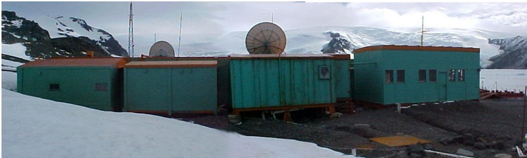
**Figura 7 - Vista lateral da EACF onde são perceptíveis as reentrâncias e saliências oriundas do processo de crescimento por unidades compartimentadas (contêineres).**
