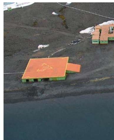
Figura 6 - Vista aérea do heliponto
