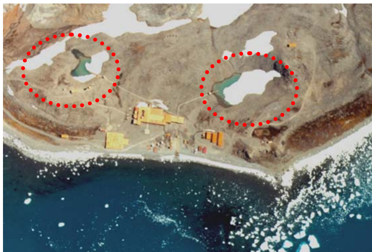
Figura 1 – Vista aérea do sítio de implantação da Estação Antártica Comandante Ferraz com ênfase para as lagoas de captação de água.
