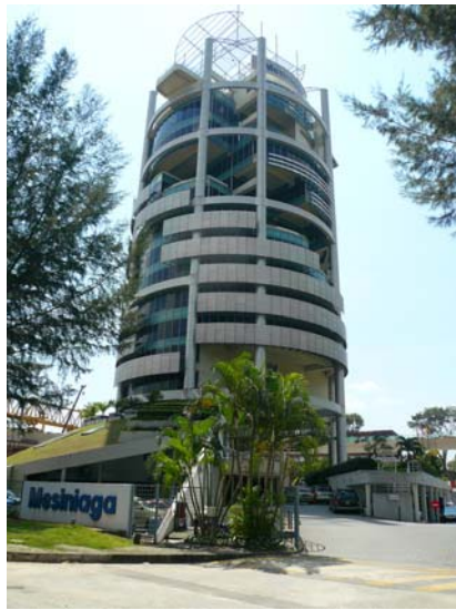
Figura 4 - Edifício Menara Mesiniaga de Ken Yeang na Malásia (RYAN, 2007).
