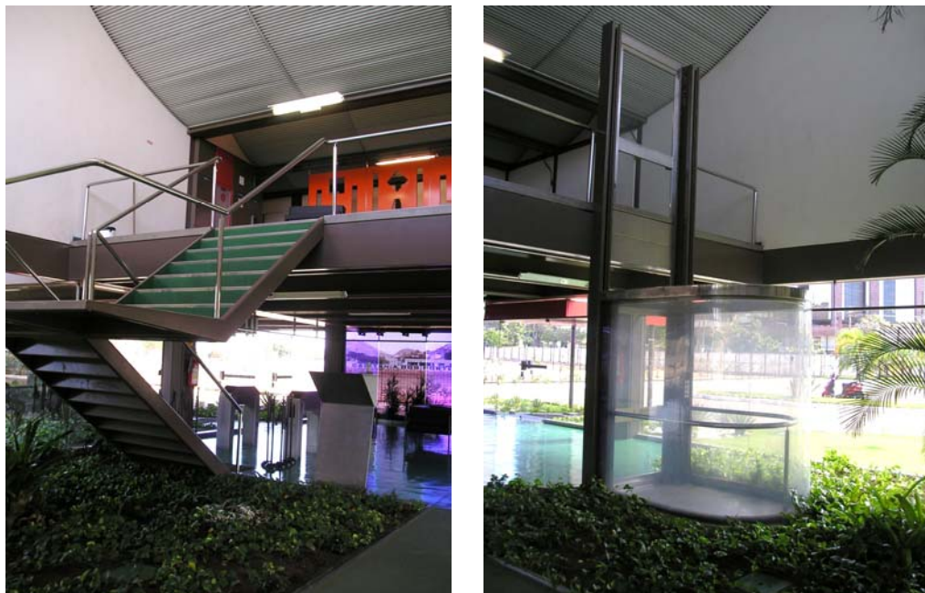
Figura 25 - À esquerda e à direita, hall da recepção no térreo e espaço de articulação com circulação vertical.
