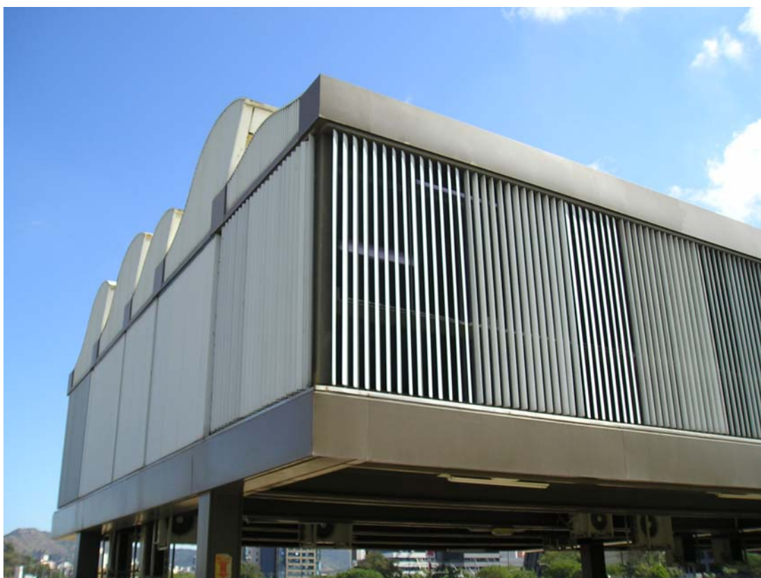
Figura 30 - Vedação das salas de escritórios em vidro e brises metálicos.
