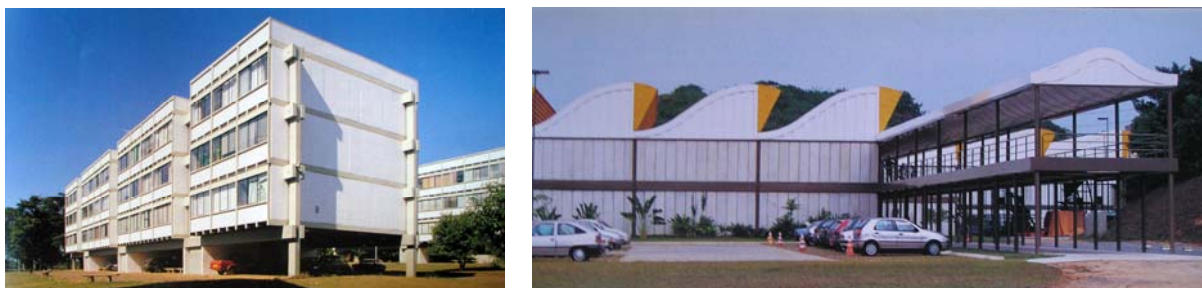
Figura 22 - À esquerda, apartamentos para professores da Universidade de Brasília em estrutura pré-moldada de concreto, construído em 1962; e à direita, edifício do Centro de Tecnologia da Rede Sarah Kubitschek (CTRS) em estrutura de aço, em Salvador, BA, construído em 1992 (LATORRACA, 1999, p. 37 e 201).
