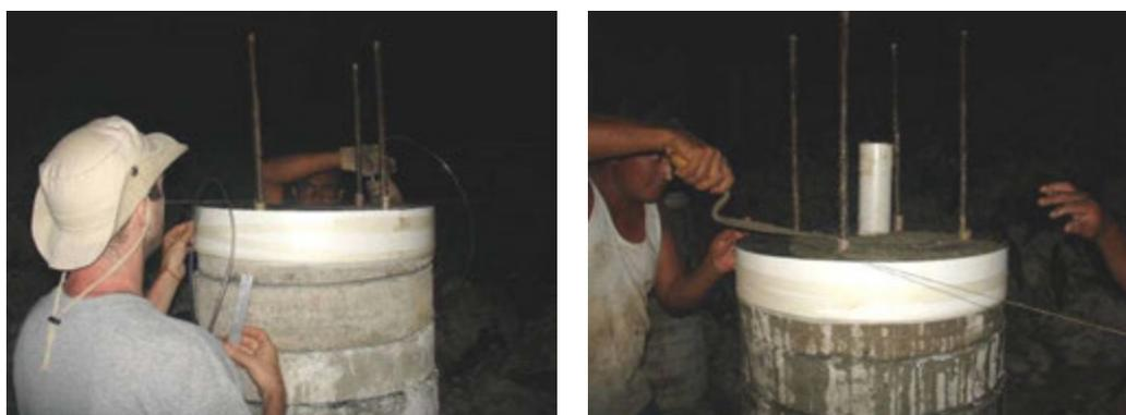
Figura 5:26 – Nivelamento dos pilaretes com argamassa e medidas tomadas com nível de mangueira para a instalação dos conjuntos amortecedores. Imagem: acervo LPP/UFES, 2007.
