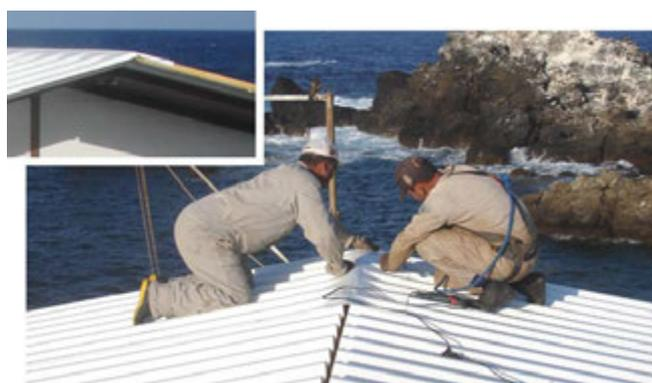
*Figura 5:58 – Colocação das peças de cumeeira, por parafusão, com transpasse da telha de alumínio e fixação na cobertura viga-laje. Imagem: acervo LPP/UFES, 2007.*
