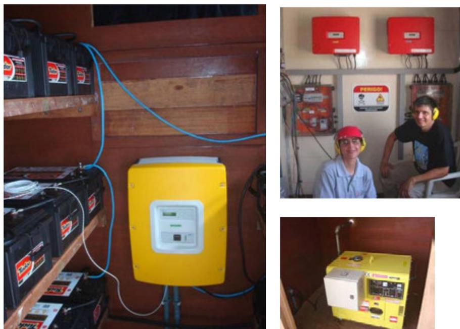
Figura 5:81 – À esquerda, instalação do inversor bidirecional; acima à direita, os 2 inversores instalados e os engenheiros do CEPEL e, abaixo à direita, o gerador.
