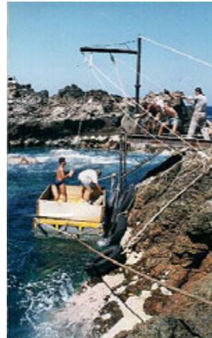
Figura 2:15 - À esquerda, aspecto do turco nos dias de maré alta com ondas de maior intensidade e à direita, a chegada das peças com “cabrita” e desembarque final através de içamento por guincho de força. Imagem: ALVAREZ, 2001, p.62.
