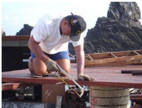
Figura 5:39 – À esquerda, confecção do rebaixo na peça de madeira ao redor da porca, para permitir a entrada da ferramenta de aperto. O sulco é feito com folga permitindo a movimentação da porca, não comprometendo o aperto das peças seguintes. À direita, finalização de um segmento do piso, com o acabamento da barra rosqueada para a colocação da luva onde será encaixada a próxima barra, dando seqüência ao piso. Imagens: acervo LPP/UFES, 2007.
