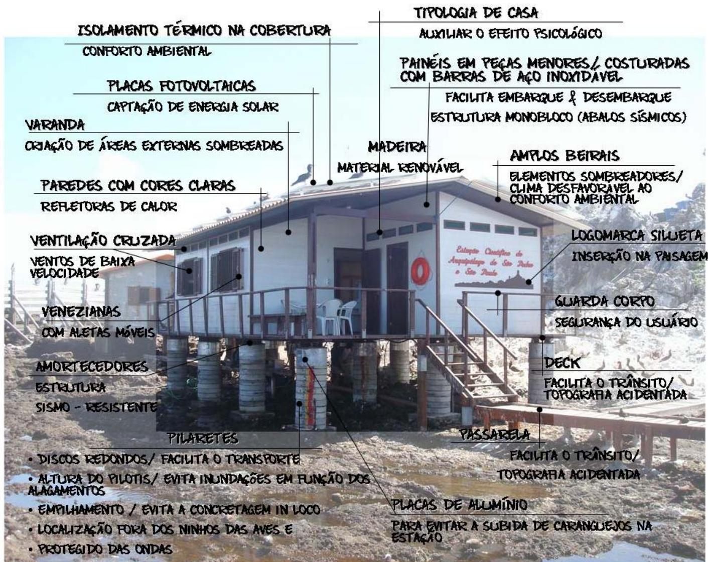
Figura 6:3 - Indicação dos reflexos dos principais condicionantes ambientais, limitações logísticas e os cuidados com o ambiente na arquitetura da nova ECASPSP. Fonte: Imagem modificada a partir de foto do acervo do LPP/UFES, 2007.
