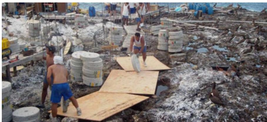
Figura 5:13 – Transporte vertical dos discos de concreto, componentes das fundações.
