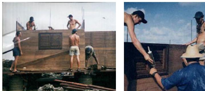
Figura 2:17 - Montagem das paredes e vedação das janelas com silicone objetivando maior estanqueidade dos elementos de fechamento. Imagem: ALVAREZ, 2001, p.64.
