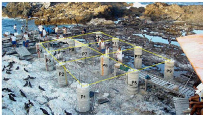
Figura 5:22 – Aspecto geral do canteiro de obras na finalização da 1ª expedição, que foi encerrada após o encaixamento dos discos de concreto e manta asfáltica nas barras de aço rosqueáveis.
