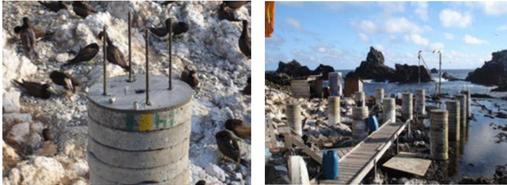
Figura 5:27 – À esquerda, P2 nivelado e, à direita, aspecto geral do canteiro com pilaretes nivelados onde se pode observar também o nível de maré e o alagamento da Ilha. Imagem: acervo LPP/UFES, 2007.
