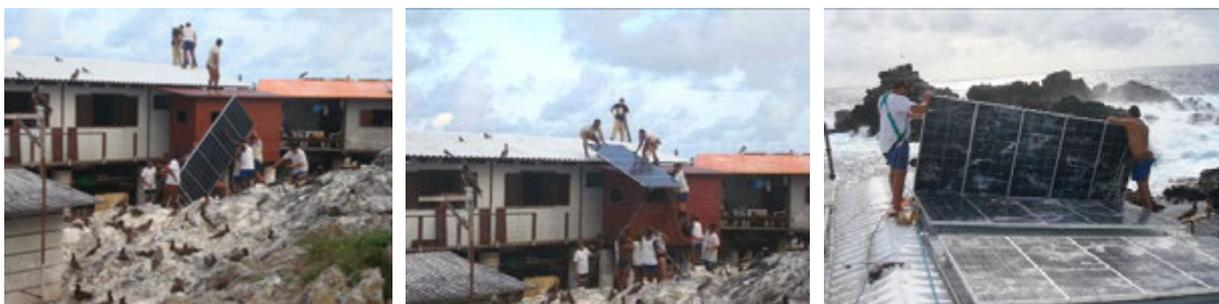
Figura 5:79 – Transporte dos painéis já montados à cobertura da Estação, onde foram instalados. Fonte: M.A. Carvalho, 2008.
