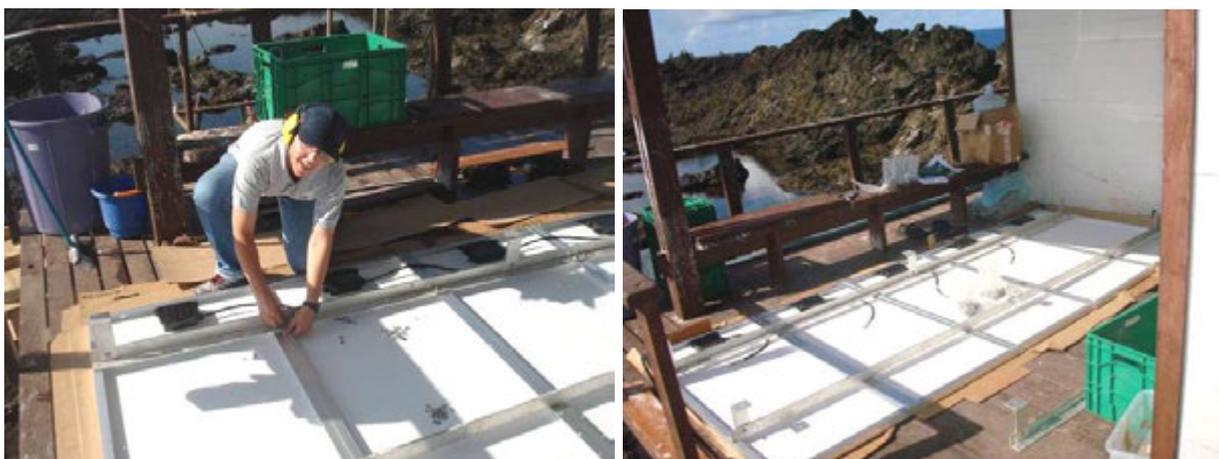
Figura 5:78 – Montagem dos painéis FV. Fonte: M.A. Carvalho, 2008.
