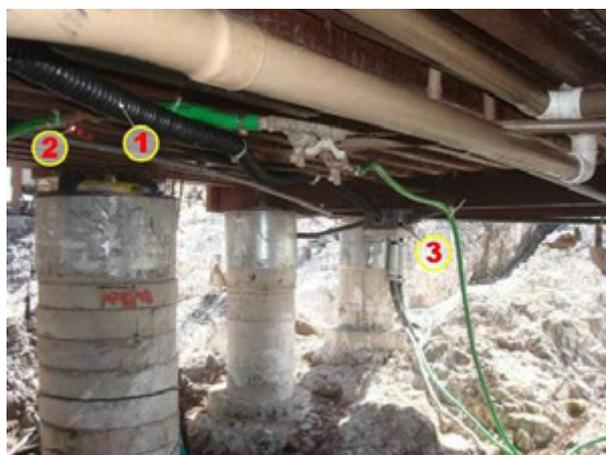
Figura 5:90 – À esquerda, filtro do sistema de dessalinização (1 - água que vem do dessalinizador para ser filtrada; 2 - filtro; 3 - salmoura, lançada ao mar; 4 - água que retorna para o dessalinizador; e 5-comando elétrico do sistema). À direita, instalações prediais (1 - conduíte EMBRATEL e GESAC, 2-água doce, 3-caixa de passagem). Fonte: M. A. Carvalho, 2008.
