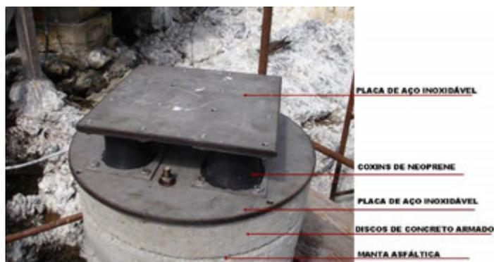
Figura 5:29 – Coxins já associados aos discos de concreto com as devidas adequações, sendo tal procedimento repetido para os 12 apoios da nova ECASPSP. Fonte: LPP/UFES, 2007.
