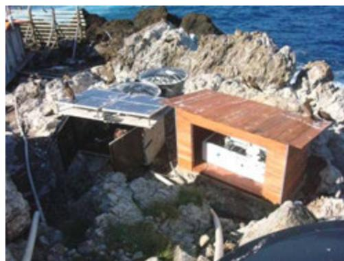
Figura 5:87 – À esquerda, transporte horizontal do dessalinizador, pesando aproximadamente 160 kg, no canteiro de obras. À direita, o dessalinizador, já posicionado para a instalação e protegido das intempéries. Fonte: acervo SECIRM, 2008.
