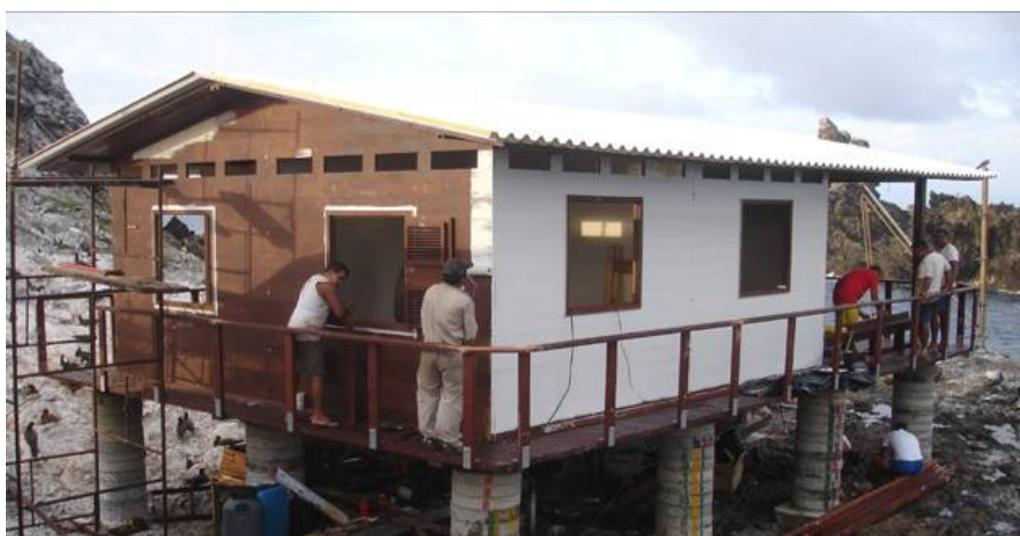
Figura 5:60 – Pintura dos painéis externos e a fixação da telha de alumínio da cobertura já concluída. Imagem: acervo LPP/UFES, 2007.
