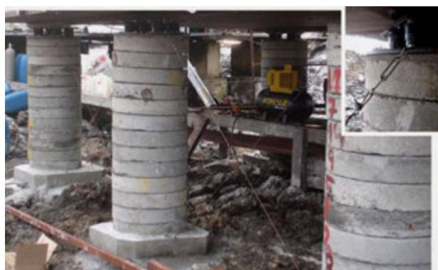
Figura 5:61 – Fixação dos cabos de aço para o contraventamento. No detalhe, ligação do tensor com a chapa metálica inferior do conjunto amortecedor. Imagem: acervo LPP/UFES, 2007.
