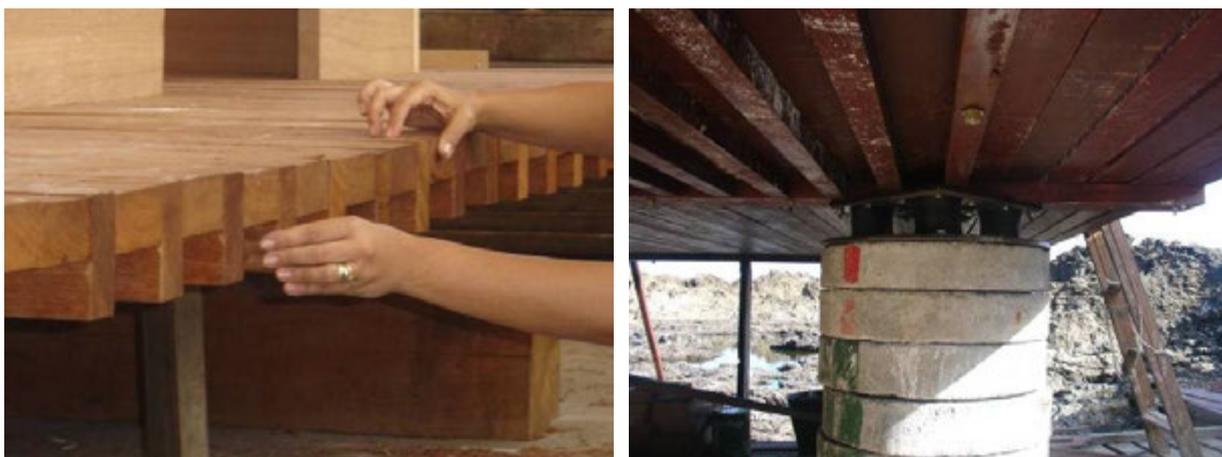
Figura 5:77 – À esquerda, estrutura do piso do compartimento de baterias, na pré-montagem na BNN e, à direita, vista inferior do piso depois de montado no Arquipélago. Imagens: Acervo LPP/UFES, 2007.
