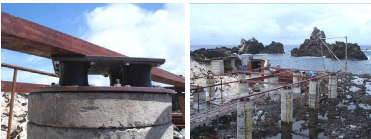
*Figura 5:38 – Colocação da viga de apoio do piso da Estação. À esquerda, em destaque, a associação das fundações com o piso e, à direita, o desenvolvimento da atividade de colocação do piso no canteiro. Imagens: LPP/UFES, 2007.*
