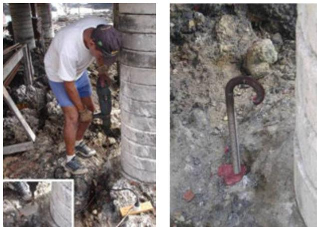
Figura 5:32 – À esquerda, perfuração do solo para fixação dos ganchos de amarração dos cabos tensores e, à direita, ganchos para a fixação dos cabos tensores. A fixação foi feita com o sistema Adesivo HIT RE 500, da HILTI. Imagem: acervo LPP/UFES, 2007.
