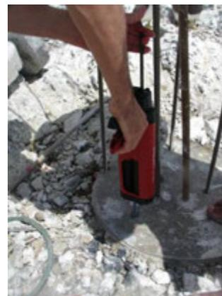
Figura 5:18 – À esquerda, furos para a ancoragem (martelo demolidor SDS MAX2 e brocas 40x 3/4'' – HILTI) e, à direita, aplicação da resina (chumbador químico) para a ancoragem das barras de aço.
