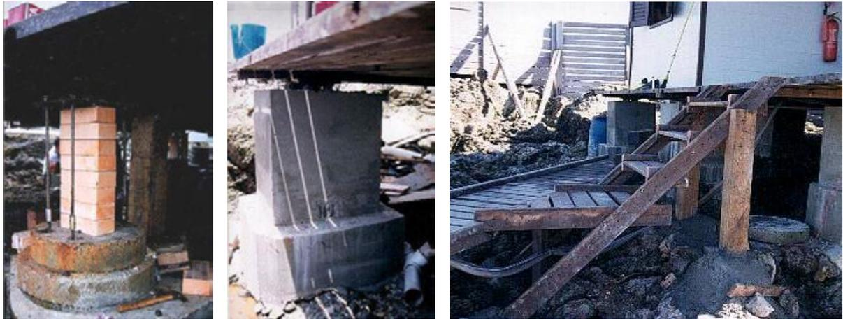
Figura 2:26 – Elevação da edificação principal e reforço das sapatas. À direita, a escada para vencer o novo nível do piso, depois da elevação concluída. Imagem: acervo LPP/UFES, 1998.
