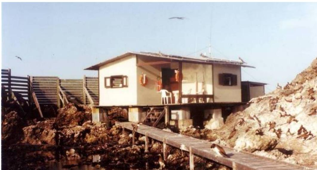
Figura 2:27 – Vista geral da edificação depois de concluídas as obras de elevação das sapatas. Imagem: acervo LPP/UFES, 2000.
