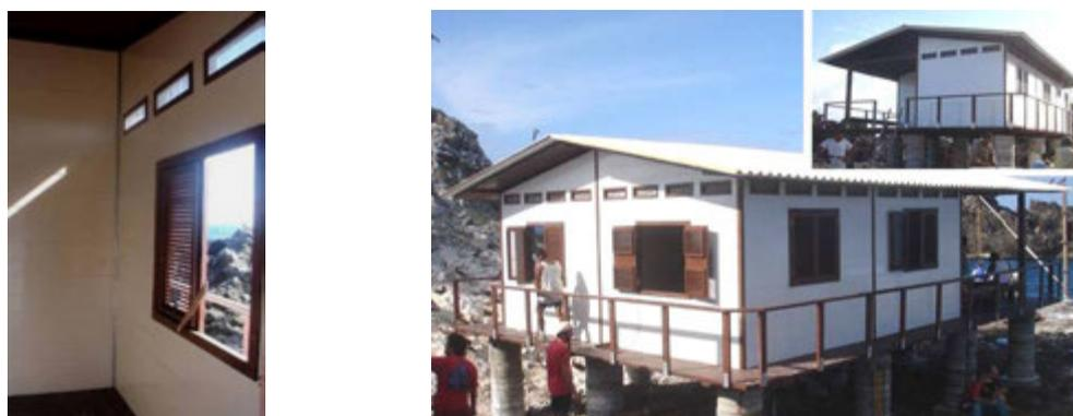
Figura 5:65 – À esquerda, a cantoneira de alumínio instalada nos vértices da edificação, para fins de acabamento e, à direita, as cantoneiras externas já revestidas com as peças de acabamento em madeira. Imagem: Acervo LPP/UFES, 2007.
