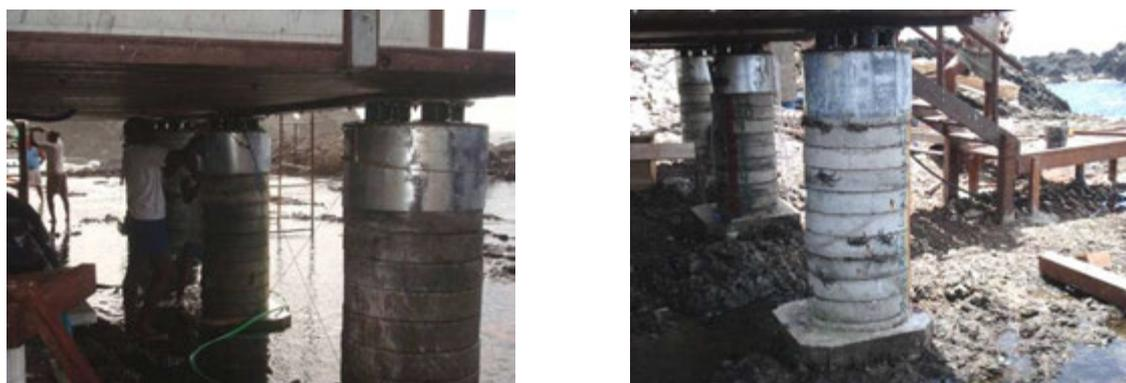
Figura 5:33 – Placas de alumínio instaladas no topo dos pilaretes. Pela ausência de rugosidade os caranguejos são impedidos de subir para os ambientes da Estação. Imagens: M.A. Carvalho, 2008.
