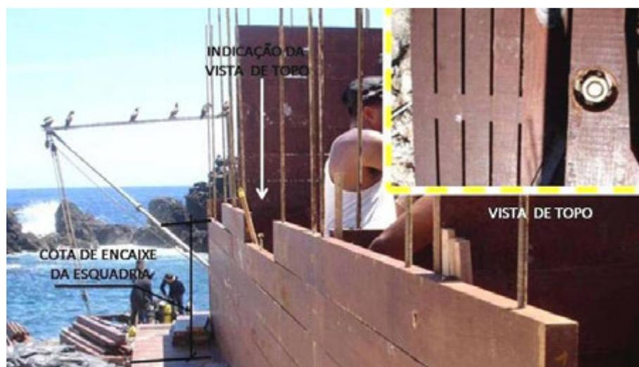
Figura 5:44 – Encaixe das peças de madeira até a cota de encaixe da esquadria. No detalhe, vista de topo da porca e arruela que finalizam a associação do painel de vedação com o piso da Estação. Imagens: acervo LPP/UFES, 2007.
