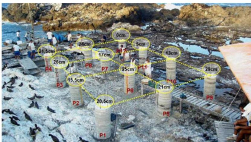
Figura 5:25 – Indicação das diferenças de nível dos pilaretes a partir do P12, estabelecido como nível zero.
