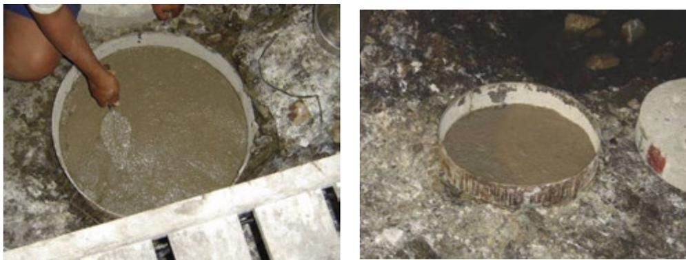
Figura 5:16 – Nivelamento da base do pilarete P1, com argamassa tixotrópica resistente a sulfatos e cloretos.
