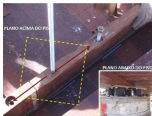
Figura 5:42 – À esquerda, locação da linha base dos painéis de vedação, e, à direita, os furos adicionais feitos “in loco” para a fixação dos painéis nos locais onde a placa superior do conjunto amortecedor impediu o transpasse da barra rosqueada, que pode ser observada em destaque. Fonte: acervo LPP/UFES, 2007.
