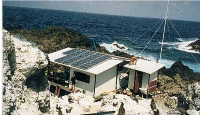
*Figura 2:18 – Vista geral da edificação principal da primeira Estação Científica, e as placas fotovoltaicas dispostas nas duas águas do telhado de forma a manterem dois sistemas independentes com a mesma capacidade de captação solar. Imagem: ALVAREZ, 2001, p.68.*
