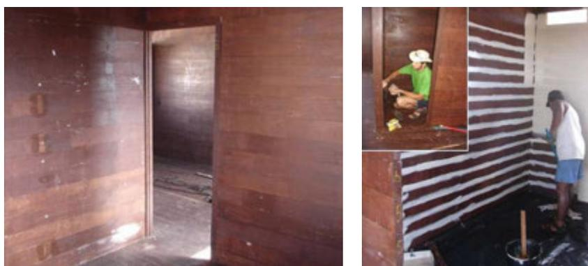
Figura 5:53 – À esquerda, colocação dos marcos das esquadrias executada em paralelo ao trabalho de montagem da cobertura, nos quadrantes já cobertos e à direita, a limpeza para retirada dos resíduos, especialmente a graxa excedente das barras rosqueadas, precedeu a pintura. Imagem: acervo LPP/UFES, 2007.
