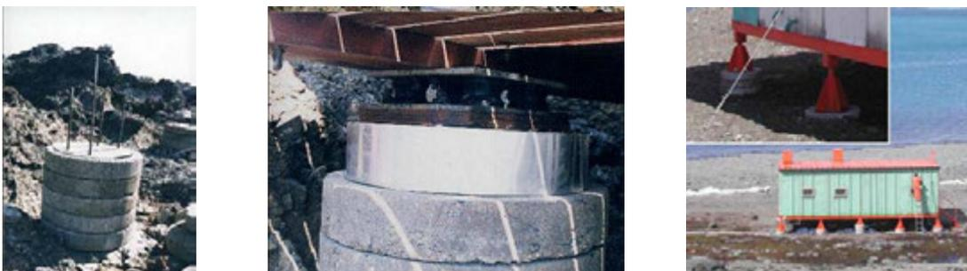
*Figura 2:13 – À esquerda, discos de concreto unidos por camada de manta asfáltica e barras rosqueadas ao centro, o conjunto com os amortecedores instalados. Imagem: ALVAREZ, 2001, p. 59. À esquerda, módulo Laboratório de Química na Estação Antártica Comandante Ferraz, onde os desníveis do terreno são compensados pelo empilhamento das bolachas de concreto e parafusos niveladores na porção metálica. Fonte: acervo LPP/UFES, 2006.*
