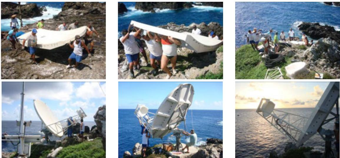
Figura 5:94 – Na seqüência acima, transporte dos componentes da antena no canteiro, do desembarque ao local de instalação e, abaixo, seqüência de montagem. Fonte: M. A. Carvalho, 2008.
