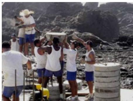
Figura 5:19 – À esquerda, início do encaixamento dos discos de concreto e manta asfáltica; à direita, força-homem para encaixamento dos discos de concreto.
