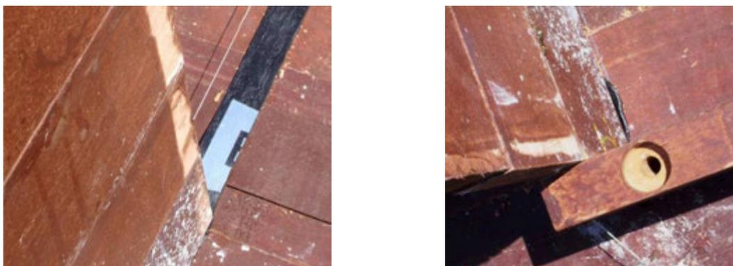
Figura 5:43 – Tiras de manta asfáltica colocadas na base dos painéis para impedir infiltrações. Fonte: acervo LPP/UFES, 2007.
