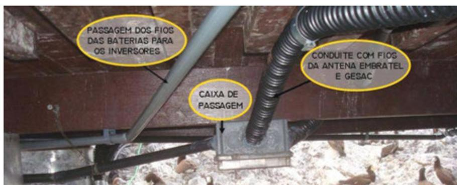
Figura 5:82 – Instalações elétricas sob a edificação principal. Fonte: M.A. Carvalho, 2008.
