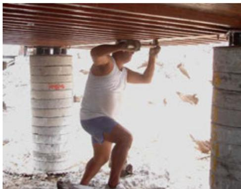
Figura 5:49 – Aperto das porcas das barras rosqueadas de associação do piso com as paredes.
