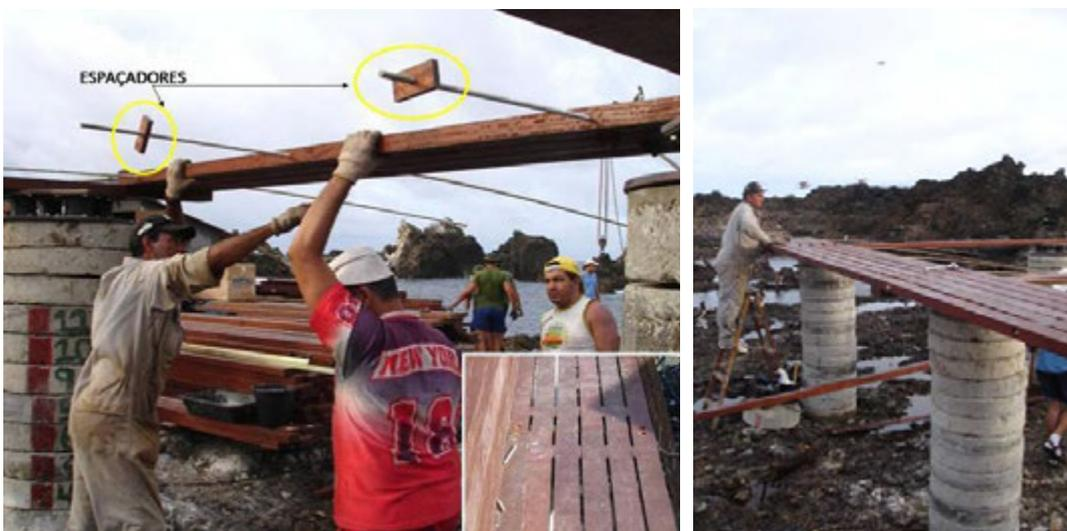
Figura 5:40 – Início da atividade de colocação do piso. À esquerda, colocação do piso com os espaçadores; no destaque, aspecto final do deck e, à direita, parte do piso da circulação externa (voltada para a enseada) já instalado. Imagem: acervo LPP/UFES, 2007. É importante observar que o uso da EPI, muitas vezes é dispensado pelos trabalhadores, devido às condições ambientais atípicas, a que estão sujeitos.
