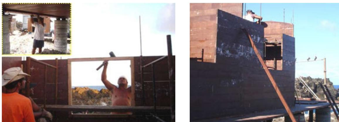
Figura 5:46 – À direita, montagem dos marcos das janelas. No detalhe, aperto parcial das barras rosqueadas associadas aos painéis de parede e, à esquerda, o escoramento para evitar o tombamento dos painéis, visando minimizar acidentes no canteiro. Imagens: acervo LPP/UFES, 2007.
