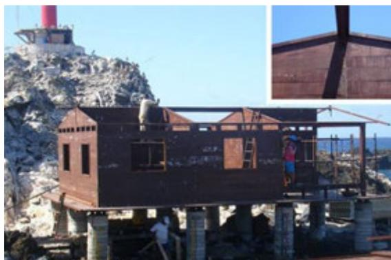
Figura 5:51 – Colocação das peças de acabamento na parte superior dos painéis. No detalhe, a linha de cumeeira. Imagem: acervo LPP/UFES, 2007.
