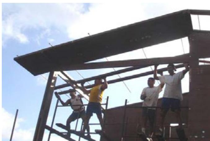
Figura 5:52 – Início da montagem com as barras rosqueadas de 300 cm, com aperto parcial das peças de madeira no ponto médio. Imagem: acervo LPP/UFES, 2007.
