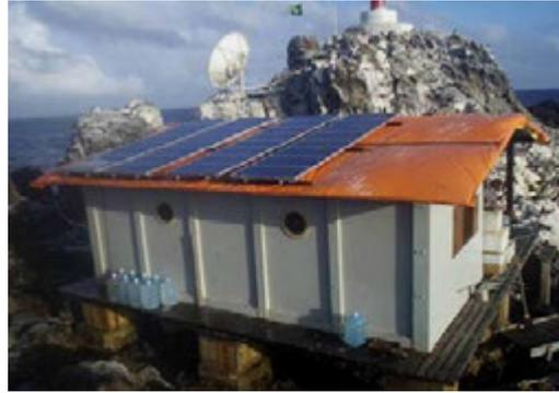
*Figura 2:34 – Vista geral da ECASPSP após as obras de restauração. Como medida provisória, a cobertura recebe uma lona plástica para evitar infiltrações provenientes de águas de chuvas e incidência das ondas. Imagem: acervo LPP/UFES, 2006.*
