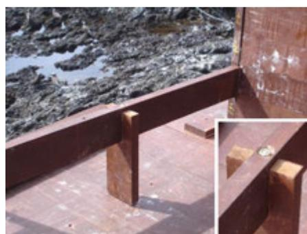
Figura 5:55 – À esquerda, fixação do banco prevista em projeto e, à direita, a execução, onde foi fixado ao piso e à viga, através de barra rosqueada com porcas e arruelas. No detalhe, o sulco ao redor da porca, para facilitar a fixação do assento do banco. Imagens: acervo LPP/UFES, 2007.
