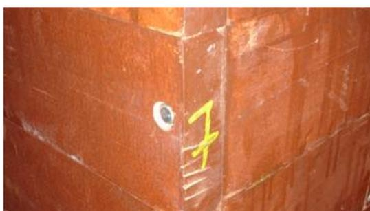
Figura 5:50 – Nos vértices dos painéis de vedação, parafusos reforçam a fixação. A madeira foi escareada para possibilitar encaixe com a cantoneira de acabamento fixada posteriormente. Fonte: acervo LPP/UFES, 2007.
