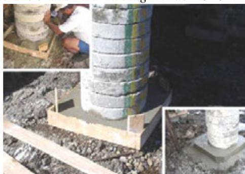
Figura 5:31 – Cintas de proteção da base dos apoios. No detalhe, à esquerda, montagem da forma e, à direita, aspecto final da base do apoio após a concretagem. Imagens: acervo LPP/UFES, 2007.
