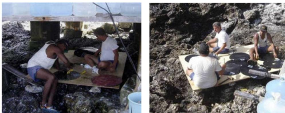
Figura 5:17 – Corte da manta asfáltica. A ausência de sombra e áreas planas para o desenvolvimento das atividades no canteiro exige improvisações visando melhores condições de trabalho.
