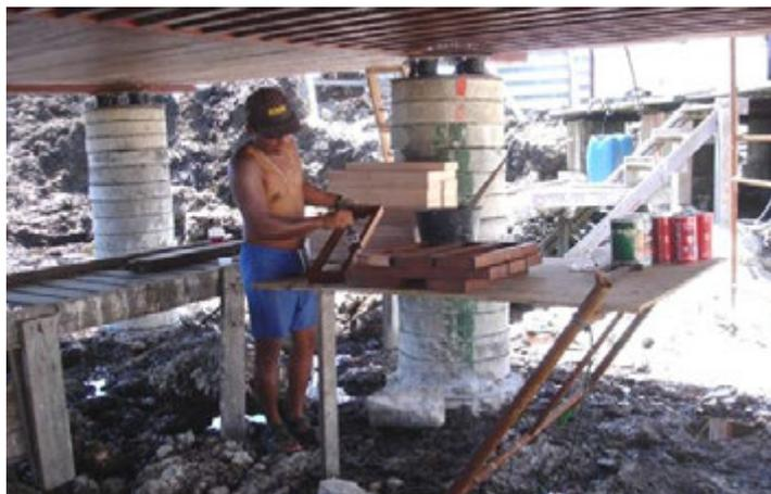
Figura 5:47 – Acabamento (aplicação de verniz) das esquadrias de ventilação. A área de trabalho foi montada sob a edificação, possibilitando maior conforto na execução das tarefas sem interferência nos fluxos das atividades já existentes. Imagem: acervo LPP/UFES, 2007.
