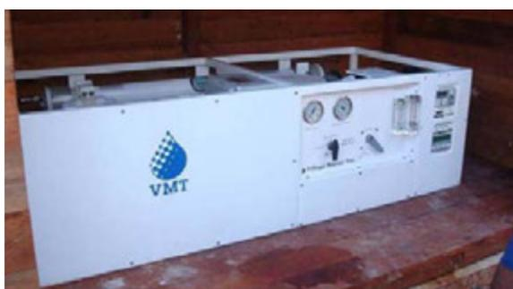
Figura 5:86 – Dessalinizador da Village Marine Technology (VMT) instalado no ASPSP. Fonte: SECIRM, 2008.
