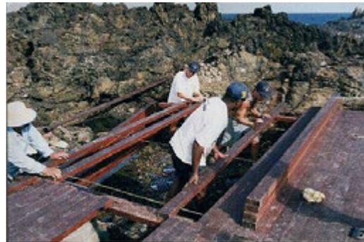
Figura 2:16 – À esquerda, croqui perspectivo do sistema viga-laje e, à direita, montagem da estrutura de madeira, formada por peças de madeira unidas através de barras rosqueadas. Imagem: ALVAREZ, 2001, p.50 e 62.
