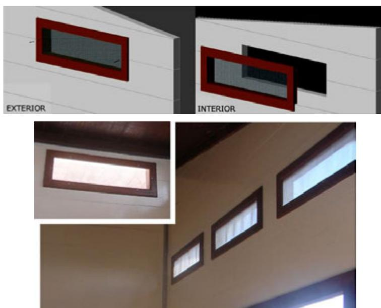
Figura 5:63 – Acima, esquema de fixação das esquadrias de ventilação. Retirando-se os parafusos libera-se a moldura (exterior), assim como o conjunto marco/tela/moldura (interior), permitindo que ambos os componentes sejam deslocados para a manutenção. Abaixo, aspecto final das esquadrias de ventilação instaladas nos painéis. Imagem: Acervo LPP/UFES, 2007.
