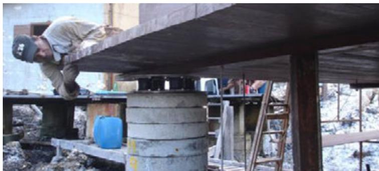
Figura 5:45 – Escoramento temporário sob a viga de suporte/apoio do piso para absorver o momento fletor da carga gradual das peças de madeira que compõem as paredes. Com o aperto das barras rosqueada, a flecha é eliminada. Imagens: acervo LPP/UFES, 2007.
