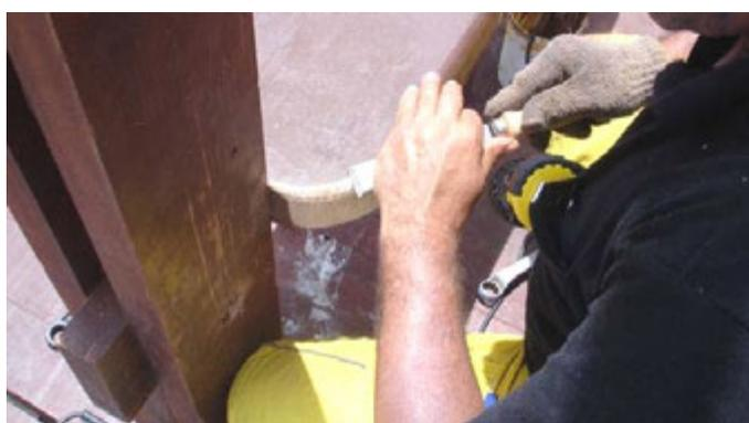
Figura 5:56 – Acabamento da peça de assento do banco, com eliminação das arestas. Imagens: acervo LPP/UFES, 2007.
