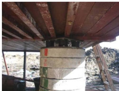
Figura 5:41 – À esquerda, colocação de peças no quadrante referente ao depósito e banheiro; e, à direita, a posição alternada das peças para reforço estrutural, tendo em vista a carga a que a estrutura estará submetida. Imagens: acervo LPP/UFES, 2007.
