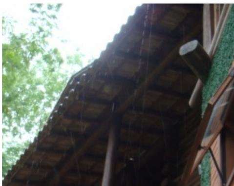
Figura 54 – Cobertura sem sistema de canalização de água de chuva.
