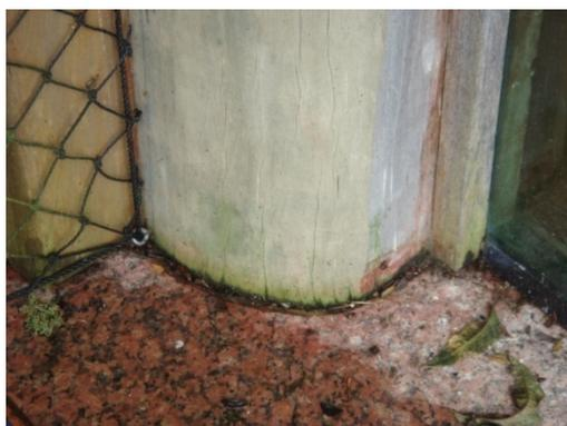
**Figura 93 – Pilar estrutural com acúmulo de umidade na base.**
