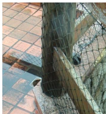
**Figura 94 – Guarda-corpo de área descoberta com grande quantidade de umidade.**
