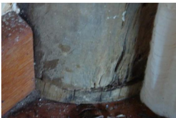
**Figura 97 – Pilar estrutural com a base, aparentemente, cortada e em início de deterioração.**
