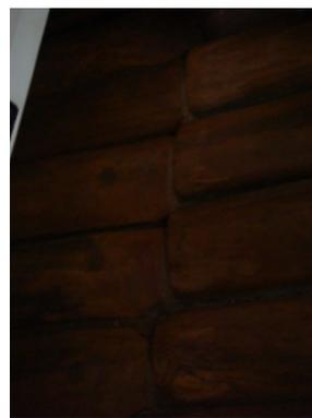
**Figura 52 – Peças desencaixadas.**
