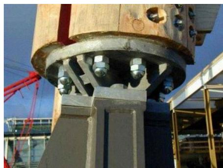
**Figura 23 - Detalhe de fixação dos pilares de madeira na estrutura metálica.**
