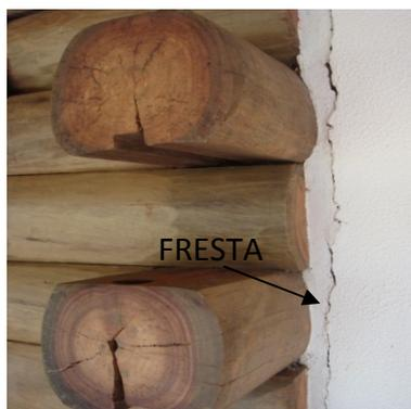
Figura 73 – Fresta entre a madeira e a alvenaria.
