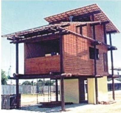
**Figura 37 - Habitação no sistema pilar/viga.**
