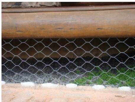
Figura 57 - Apoio da edificação sobre blocos de concreto.
