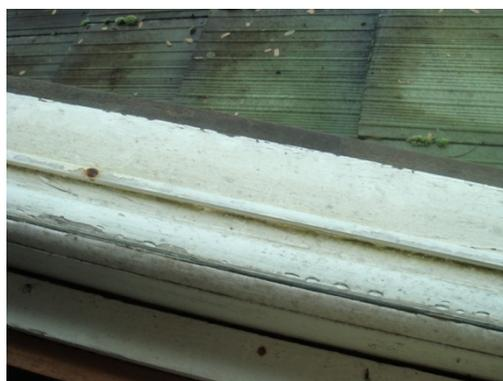
**Figura 98 – Janela sem pingadeira e com acúmulo de umidade.**
