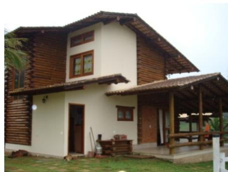
Figura 11 – Residência no sistema construtivo *log home* e convencional, Fundão, 2003.
