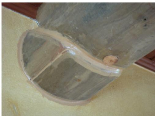
**Figura 100 – Peça com a utilização de mastique.**
