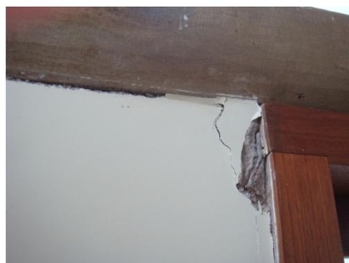
Figura 79 - Fresta no encontro da viga de madeira com a janela em uma parede interna.
