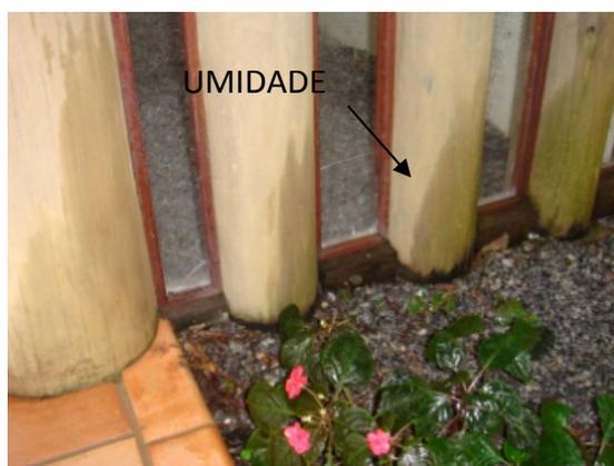
**Figura 75 – Pilar com princípio de degradação devido ao acúmulo de umidade.**
