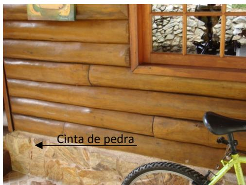
Figura 59 – Afastamento da parede em log do piso.
