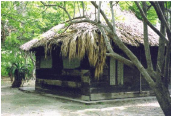
Figura 45 – Exemplos de construção no sistema construtivo semi pré-cortado.
