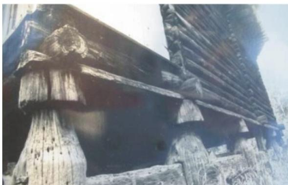
**Figura 19 – Detalhe da elevação do solo - Arquitetura primitiva chinesa.
