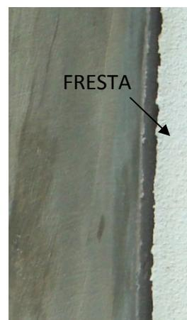
Figura 77 - Detalhe de fresta na parede externa.
