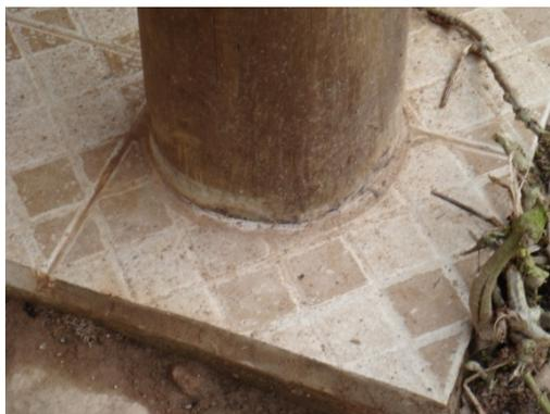
**Figura 60 – Pilares em contato direto com o piso.**
