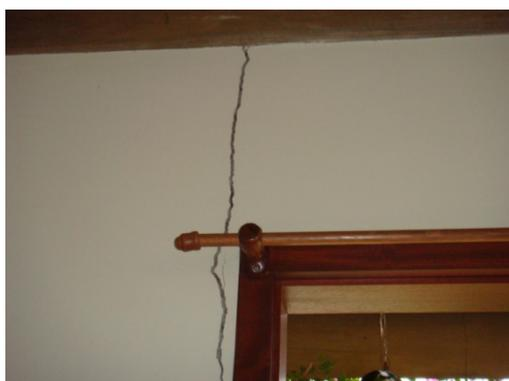
Figura 78 - Fresta vertical entre a viga de madeira e a alvenaria numa parede interna.
