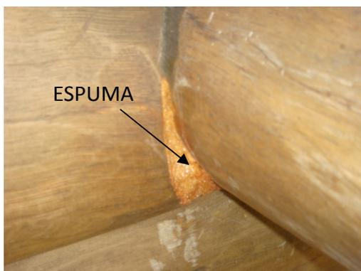
Figura 70 - Espuma utilizada para calafetar as frestas.
