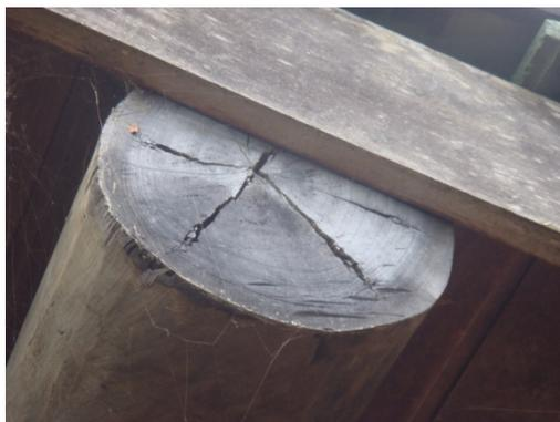
**Figura 99 – Peça do telhado com fresta e acúmulo de umidade.**
