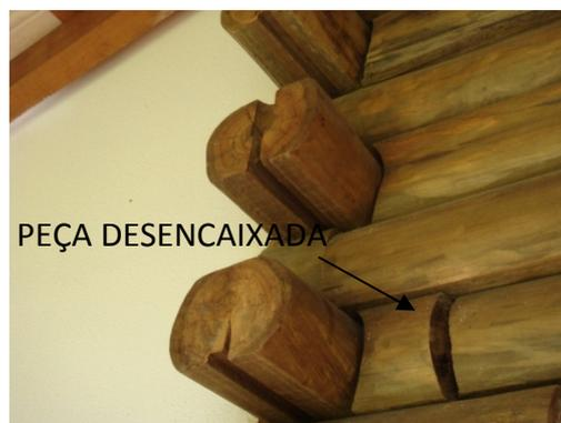
Figura 71 - Peça desencaixada.
