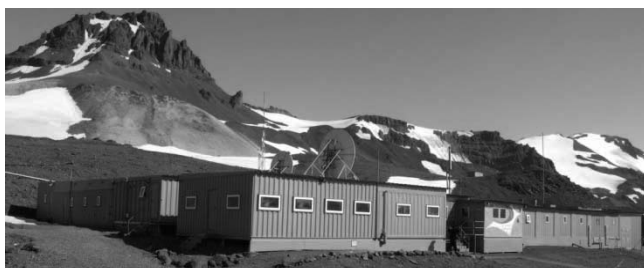
Figura 1. Vista externa frontal da EACF em janeiro de 2012.
