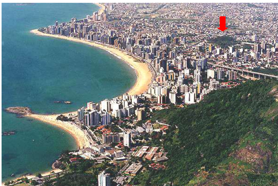
FIGURA 1: VISTA AÉREA DE PARTE DA CIDADE DE VILA VELHA, COM O MORRO DO MORENO EM PRIMEIRO PLANO E O PARQUE MUNICIPAL MARISTA IDENTIFICADO MAIS AO FUNDO
