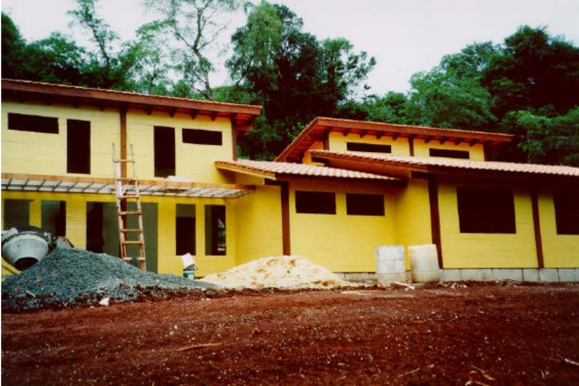
Figura 12 – Aspecto geral da obra na fase final de acabamento (sem esquadrias)
