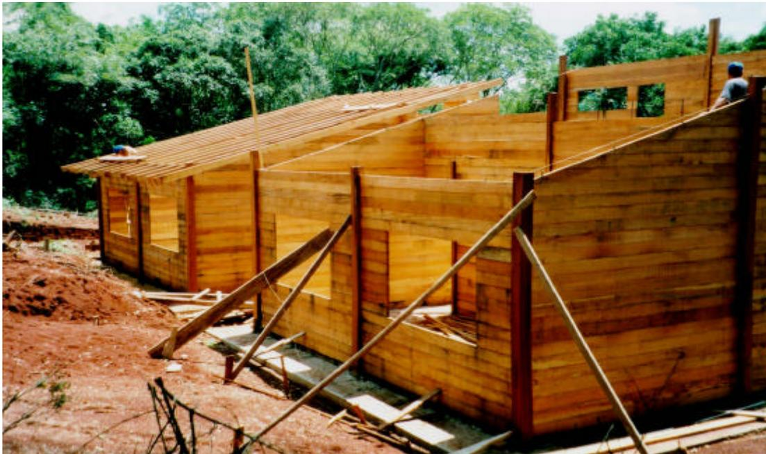
Figura 10 – Grande variedade de tonalidades nos painéis de parede da edificação
