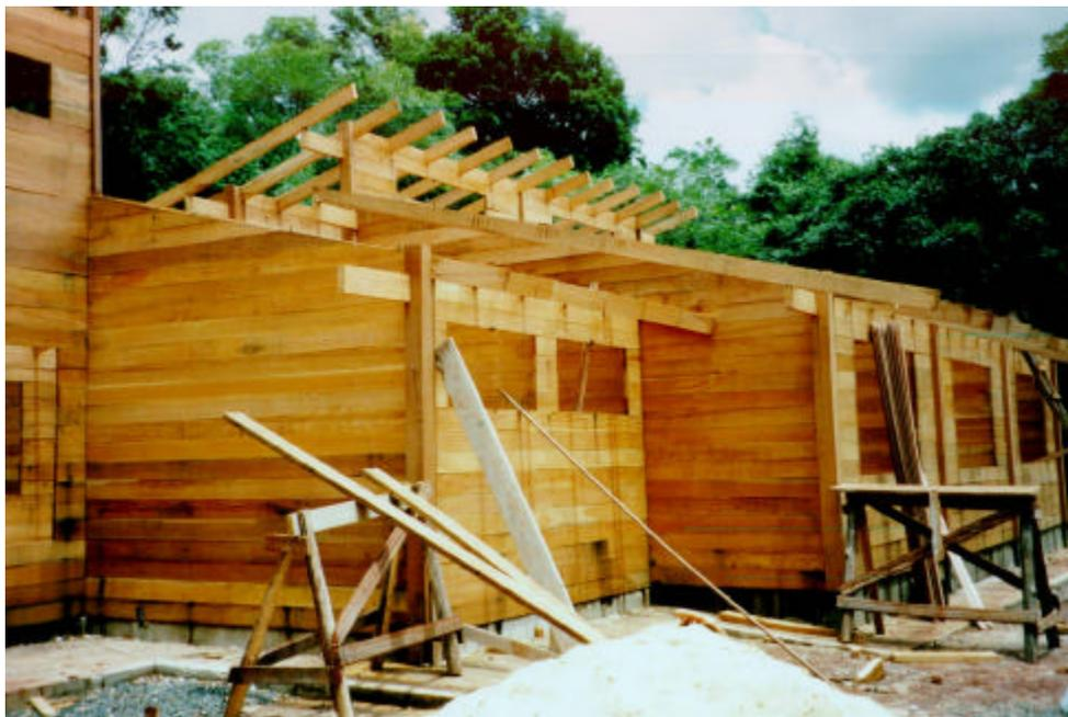
Figura 9 – Estágio mais avançado da obra, com vários painéis instalados e início de execução do madeiramento do telhado
