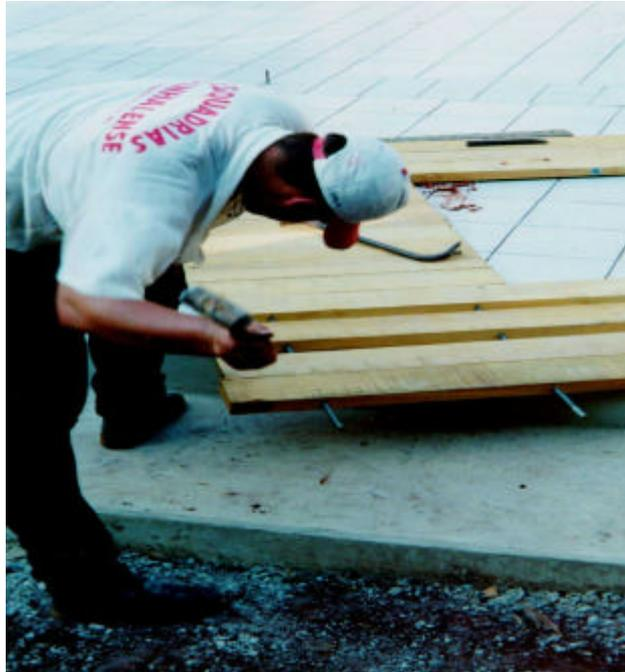
Figura 8 – Montagem de painel de parede na obra
