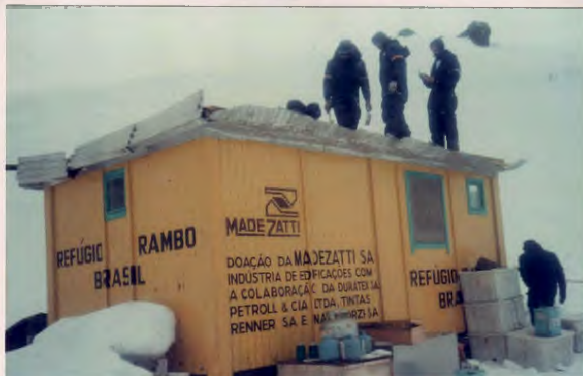
Figura 49 - Refúgio Padre Balduino Rambo - estruturado em perfis metálicos e com fechamentos em painéis sanduíche de madeira e "isopor". Em 1988, Rambo é parcialmente reformado, principalmente nas peças de cobertura (Foto da autora, 1988).
