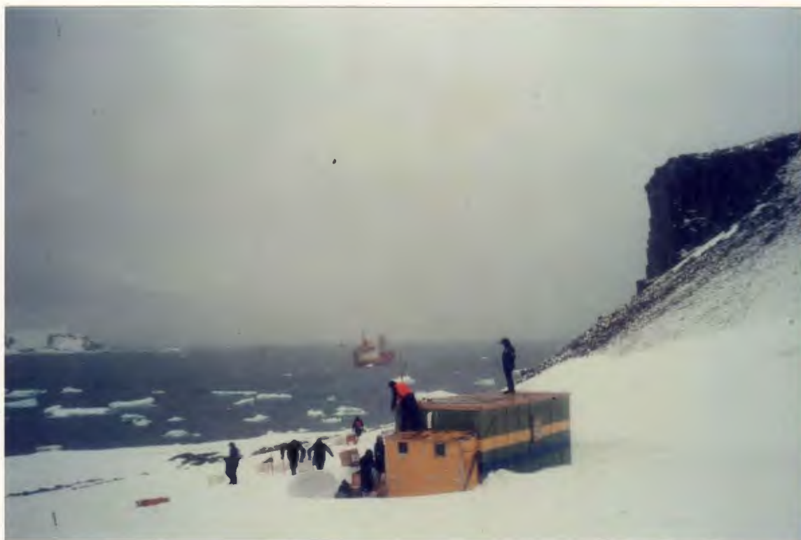
Figura 45 - Refúgio Astrônomo Cruzeiro, estruturado em aço e com painéis sanduíche composto de madeira nas faces externas e lã de vidro no interior, sendo as superfícies externas pintadas em fibra de vidro e resina poliéster (Foto da autora, 1989).
