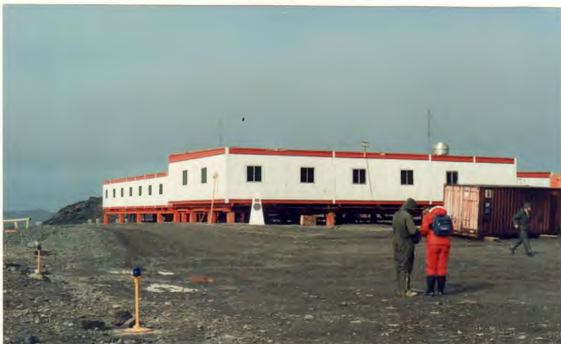
Figura 10 - Vista parcial da Base Teniente Rodolfo Marsh Martin no verão. As edificações são instaladas elevadas do solo e com cobertura quase plana. Em primeiro plano, pequenos postes com luzes que auxiliam a marcação das trilhas, visto as dificuldades na localização dos acessos nos períodos de inverno, quando o solo está constantemente recoberto de neve e gelo e são poucas as horas do dia com claridade natural (Foto da autora, 1987).
