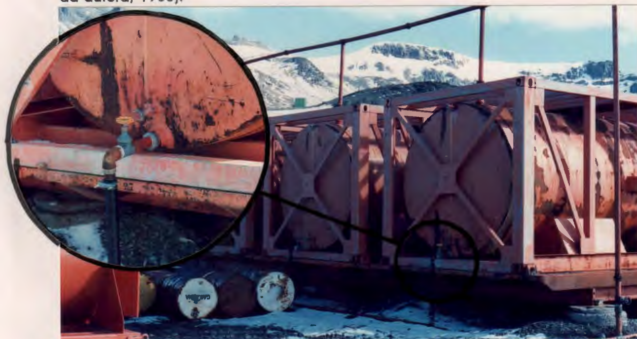
Figura 40 - Tonéis de combustível (diesel e gasolina) com perceptíveis problemas de corrosão (Foto da autora, 1988).
