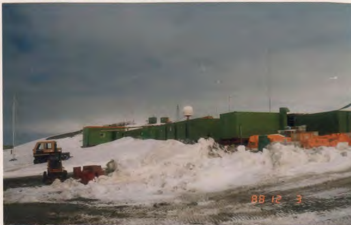
Figura 42 - Vista externa da Estação. Ao fundo (últimos módulos visíveis), laboratórios de meteorologia, com acesso sem qualquer proteção às intempéries (Foto da autora, 1988).
