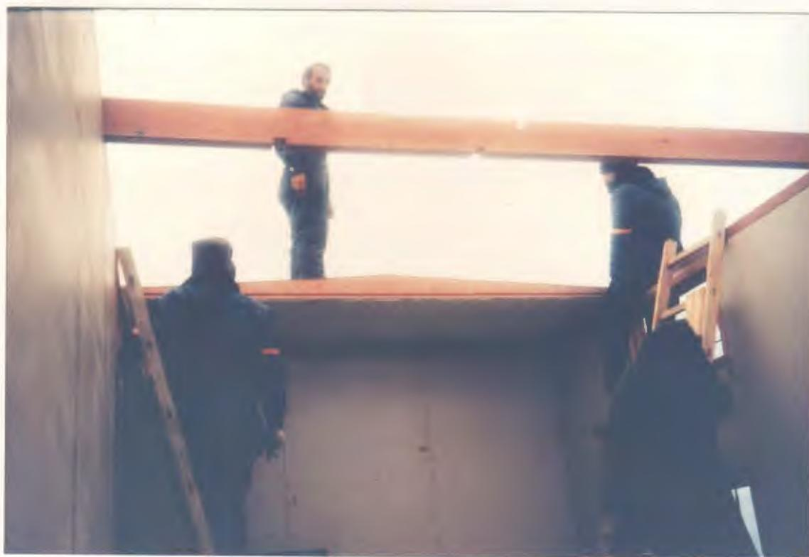
Figura 73 - Colocação dos painéis de cobertura (Foto da autora, 1988).
