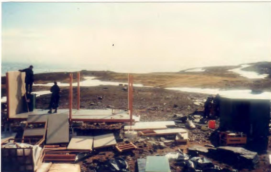
Figura 72 - Colocação dos painéis inferiores e laterais. Observa-se no entorno a geração de lixo oriundo das embalagens de todo o material e que, nesse momento, não tem mais qualquer utilidade. (Foto da autora, 1988).
