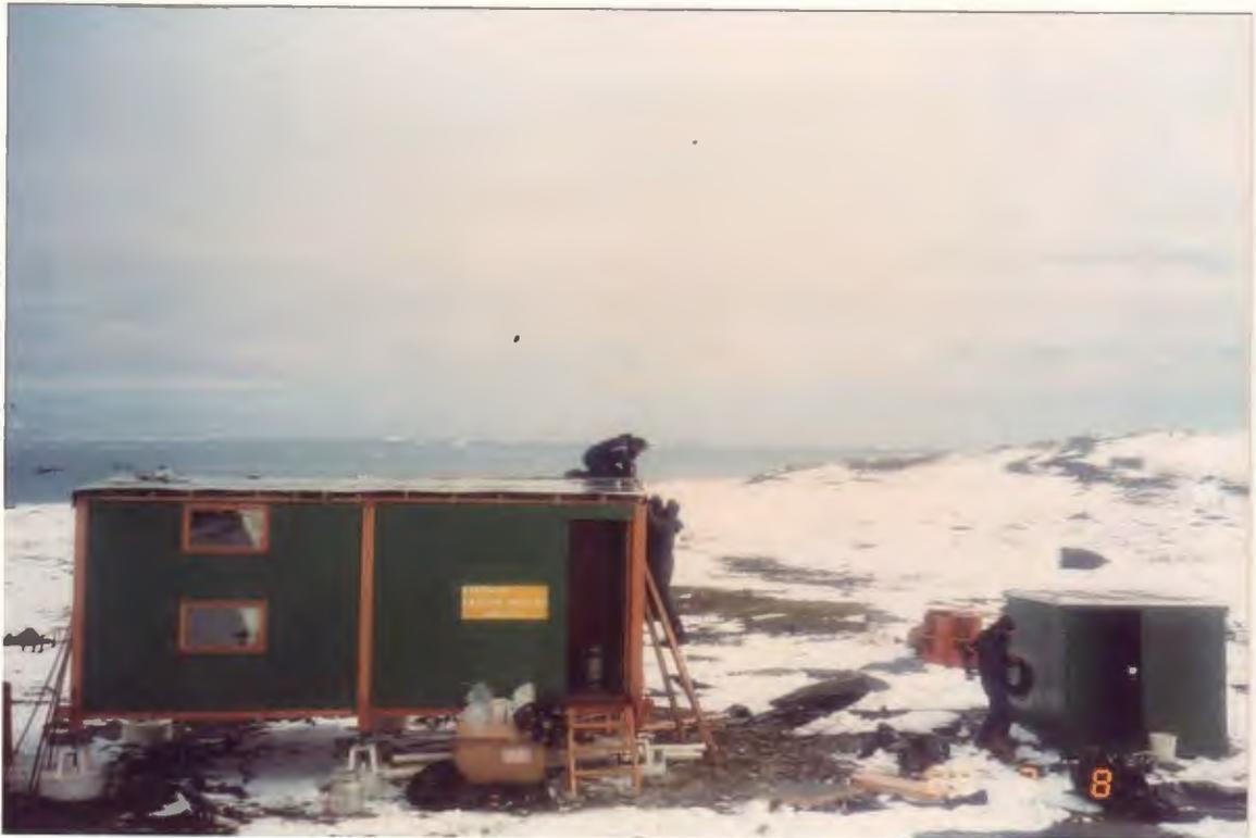
Figura 76 - Recobrimento final da cobertura com folhas de alumínio rebitadas entre si (Foto da autora, 1988).
