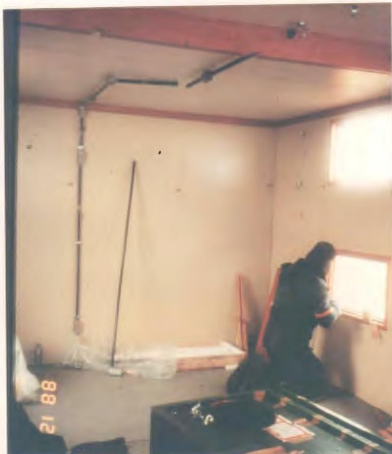
Figura 74 - Vista interna com a colocação do segundo vidro nas esquadrias e instalações elétricas (Foto da autora, 1988).
