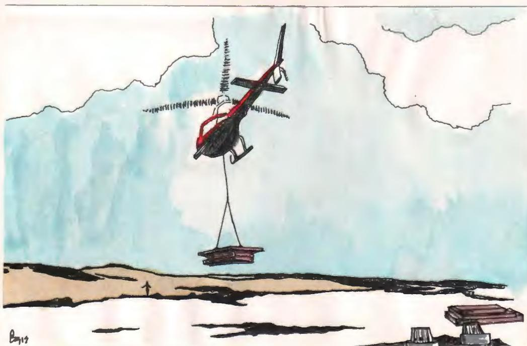
Figura 69 - Transporte das peças do navio para a Ilha Elefante e início da locação das sapatas.
