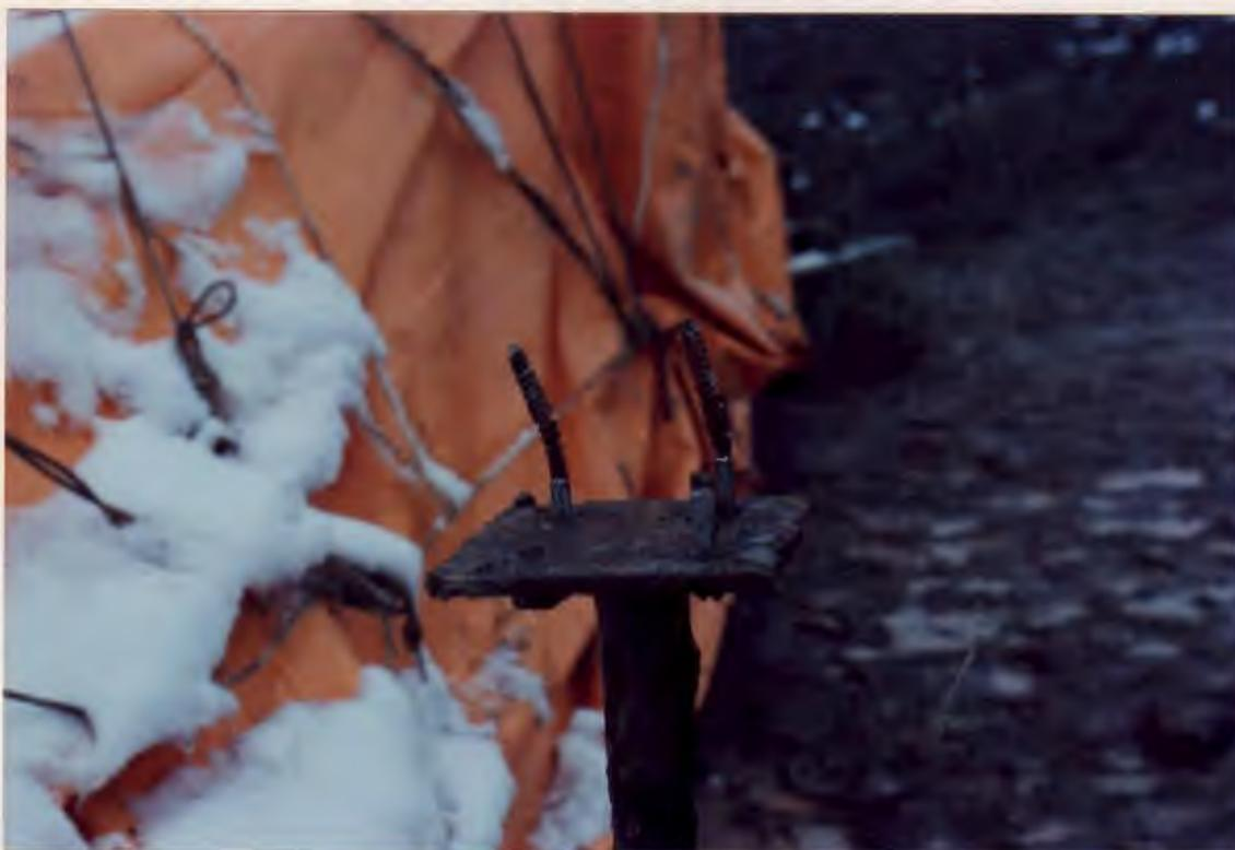
Figura 89 - Ferragem da sapata do Laboratório de Ciências Atmosféricas, demonstrando o arrancamento do pilar (Foto da autora, 1990).
