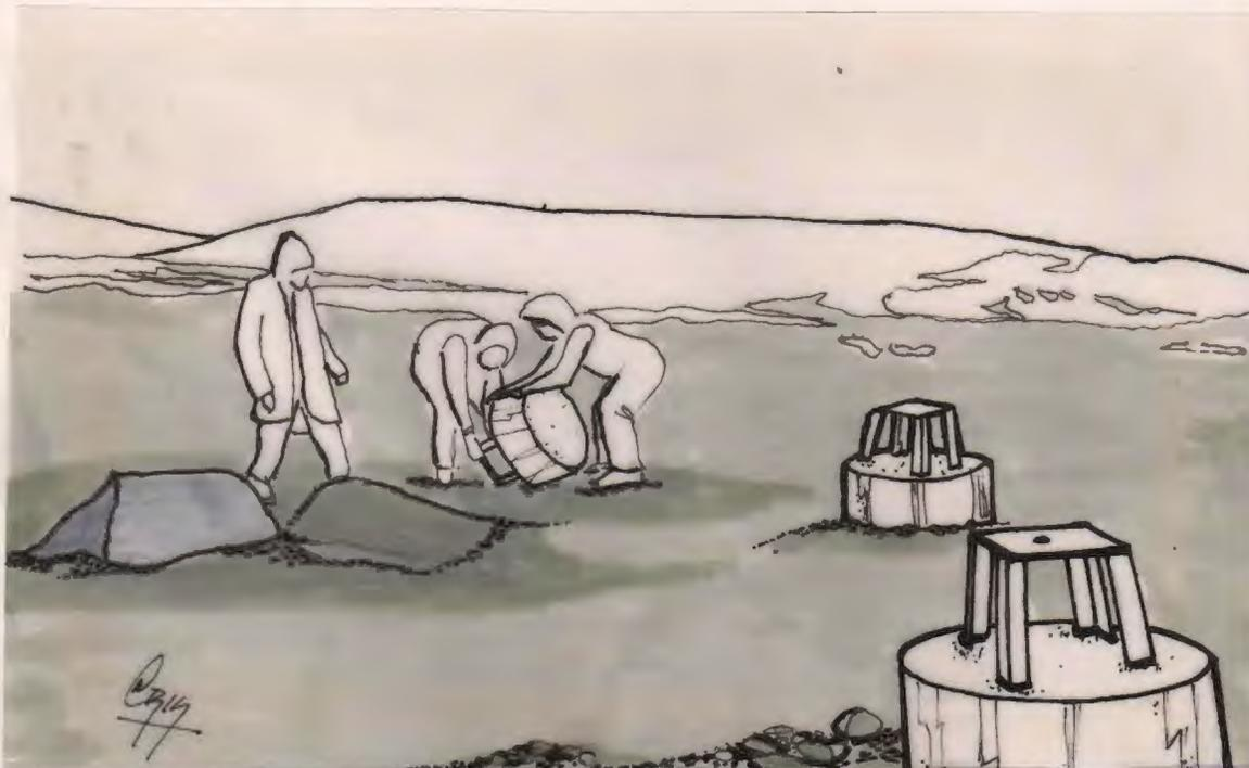
Figura 70 - As sapatas, de forma cilíndrica, são facilmente transportadas através da "rolagem" das peças.
