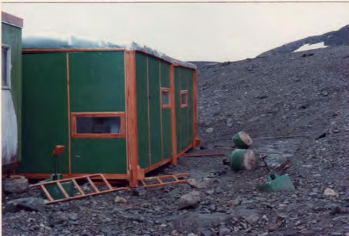
Figura 88 - Laboratório de Ciências Atmosféricas após o deslocamento. A posição final inclinada foi em função de a edificação ter se desprendido das sapatas e caído sobre as mesmas (Foto da autora, 1990).
