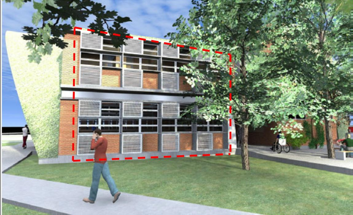
FIGURA 33: Algumas das caixas de concreto na fachada para sombreamento dos ambientes internos.
