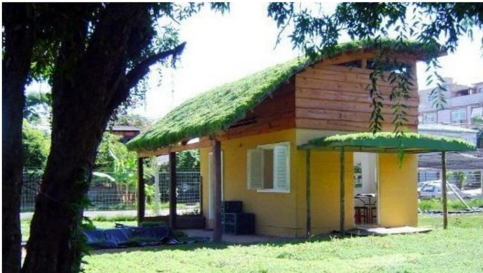
FIGURA 41: Aplicação do sistema modular de telhado verde em cobertura curva, com ângulo de curvatura semelhante ao proposto na cobertura do NEM-CAR. Fonte: ECOTELHADO..., acesso em 20 jun. 2012.
