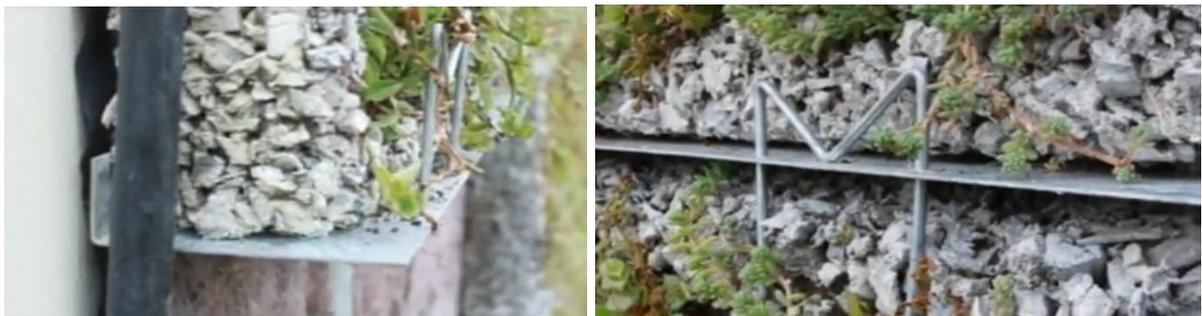
FIGURA 42: Detalhes do sistema modular de telhado verde aplicado em superfícies verticais. Fonte: ECOTELHADO..., acesso em 20 jun. 2012.
