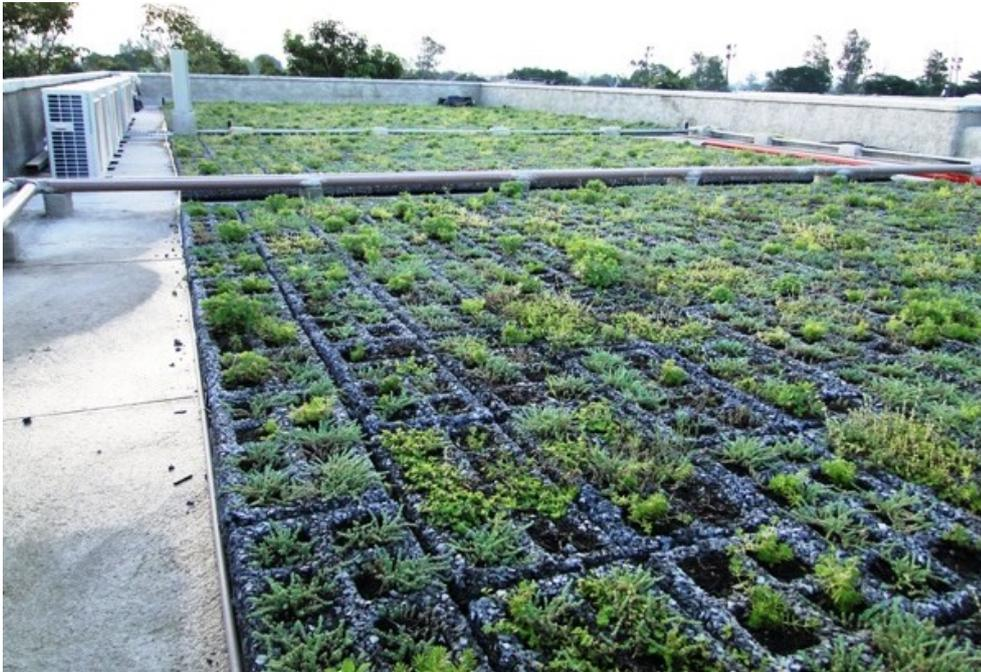
FIGURA 38: Figura mostrando o sistema modular de telhado verde especificado para o edifício, sendo possível identificar sua distribuição modular. Fonte: ECOTELHADO..., acesso em 20 jun. 2012.
