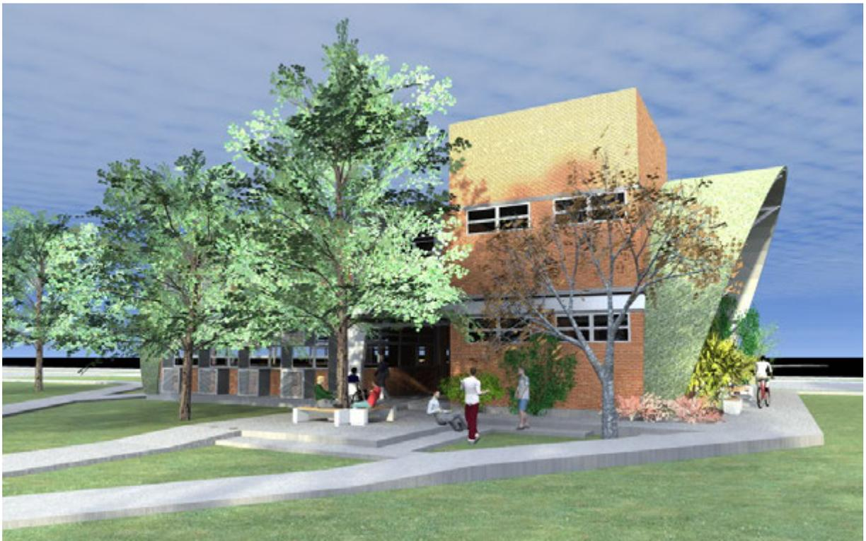
FIGURA 25: Fachada nordeste: soluções distintas da fachada sudoeste devido à forte insolação, porém com presença de árvores de grande porte ao lado.
